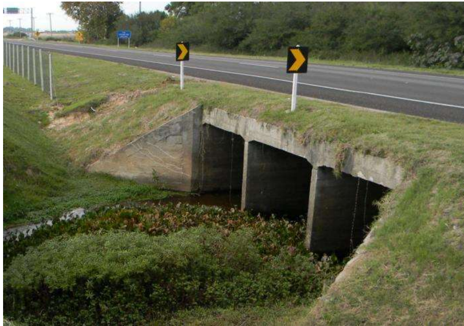
Figura 2.9: Fotografia da Seção 5 do Arroio Cabeças
