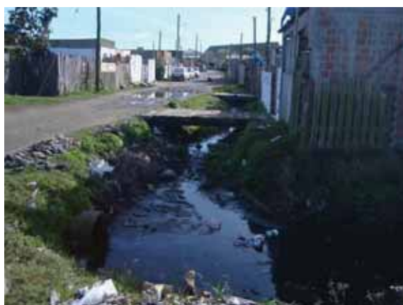
Figura 7.112: Vista de esgoto a céu aberto localizado no Bairro Getúlio Vargas. Visada no sentido Norte a partir da Rua Engenheiro Heitor Amaro Barcelos. Coordenadas UTM: 398116 E/ 6454100 N
