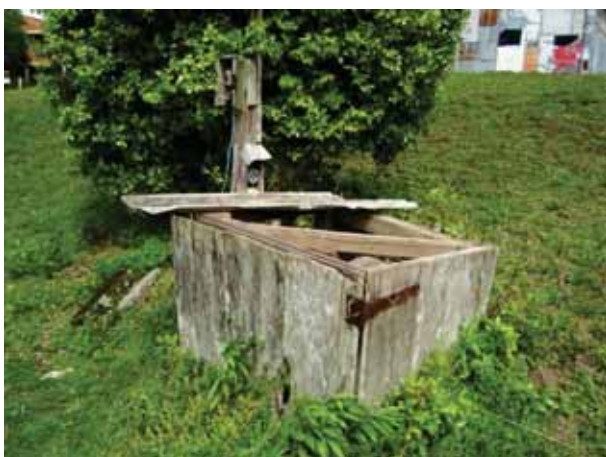
Figura 7.229: Captação de água subterrânea para uso doméstico na localidade de Capão Seco. Poço com 24 m de profundidade. Coordenadas UTM do ponto: 374.140 E / 6.474.949 N
