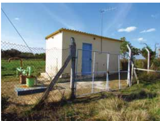
Figura 7.233: Vista de poço de captação abandonado utilizado para abastecimento público na localidade de Domingos Petrolini. Coordenadas UTM do ponto: 376.821 E / 6.459.156 N
