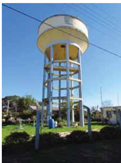
Figura 7.235: Vista do reservatório de água subterrânea captada para abastecimento público na localidade de Povo Novo. Coordenadas UTM do ponto: 376.689 E / 6.466.145 N
