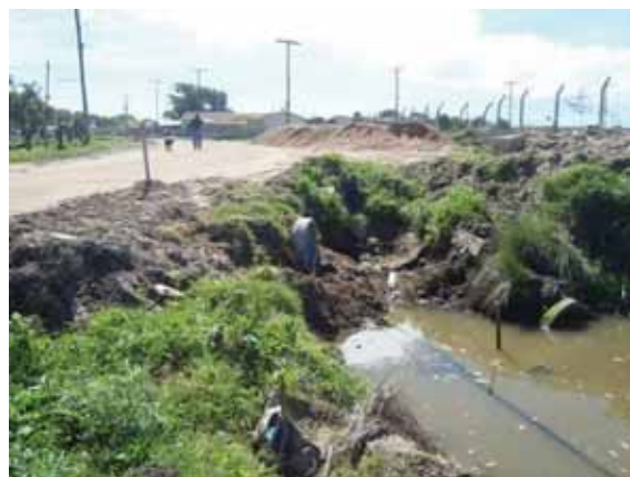
Figura 7.115: Vista de emissão de esgoto em arroio localizado na localidade de Barra Nova. Coordenadas UTM: 395739 E/ 6442173 N
