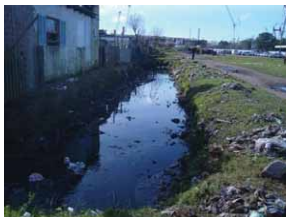
Figura 7.113: Vista de esgoto a céu aberto localizado no Bairro Getúlio Vargas. Visada no sentido Sudeste a partir da Rua Engenheiro Heitor Amaro Barcelos. Coordenadas UTM: 398116 E/ 6454100 N
