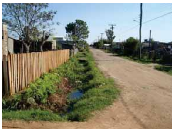
Figura 7.117: Vista de canal pluvial com esgoto a céu aberto na localidade da Quinta. Visada no sentido Noroeste a partir de arruamento interno na própria localidade. Coordenadas UTM Fuso: 380572 E/ 6451538 N
