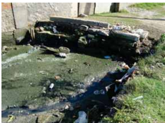
Figura 7.107: Vista em detalhe de emissão de esgoto doméstico e pluvial na Rua Capitão Lemos de Farias localizado no Saco da Mangueira, na Vila Sardinha. Coordenadas UTM: 396823 E/ 6453621 N
