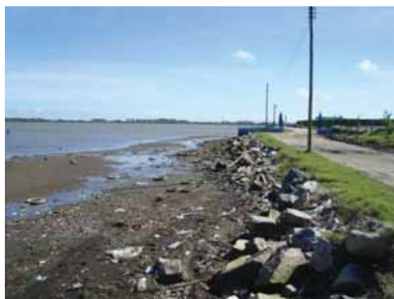
Figura 7.111: Vista do local de desembocadura do canaleta de Rio Grande, este paralelo à Avenida Major Carlos Pinto. Visada no sentido Norte a partir da Orla da Lagoa dos Patos. Coordenadas UTM: 395136 E/ 6455949 N
