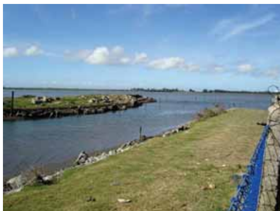
Figura 7.109: Vista do canal de emissão de efluente tratado da empresa Ipiranga. Visada no sentido Sul, o qual deságua no saco da Mangueira. Coordenadas UTM: 396851 E/ 6453598 N
