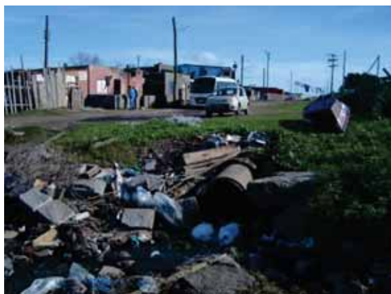
Figura 7.105: Vista de canalização de esgoto a céu aberto com descarte de lixo localizado no final da Rua Vereador Nilo Correa da Fonseca, o qual deságua no Saco da Mangueira. Coordenadas UTM: 398220 E/ 6453464 N
