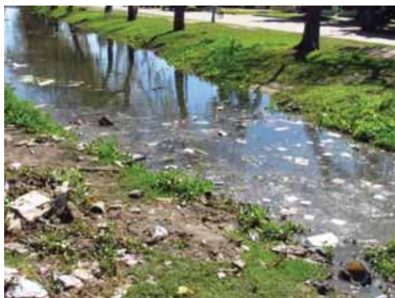
Figura 7.114: Vista em detalhe do início do canaleta de Rio Grande com esgoto a céu aberto, este paralelo à Avenida Major Carlos Pinto. Coordenadas UTM: 396027 E/ 6454170 N
