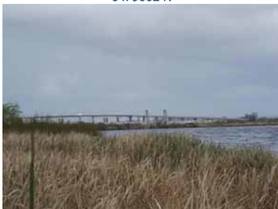
Figura 7.169: Vista a partir das margens do canal do São Gonçalo. Visada no sentido Oeste. Nota-se ao fundo a ponte da divisa do município de Pelotas e Rio Grande. Coordenadas UTM: 375430 E/ 6482878 N
