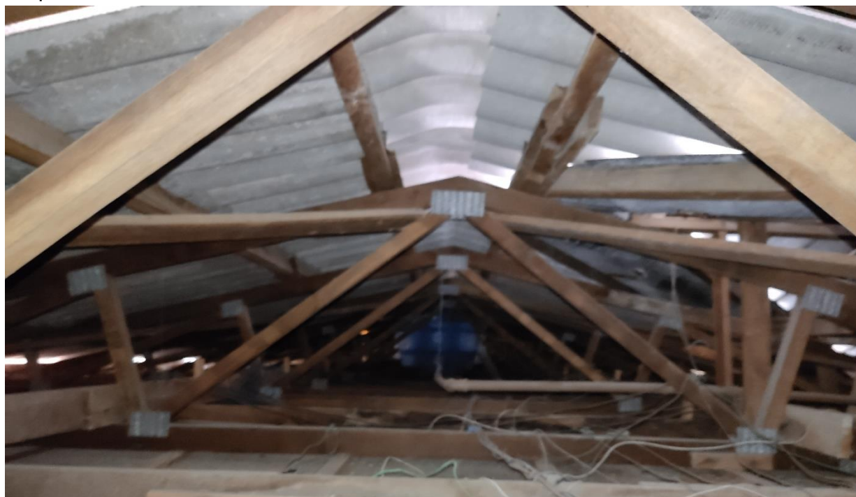
Figura 10 – Madeiramento em bom estado de conservação
