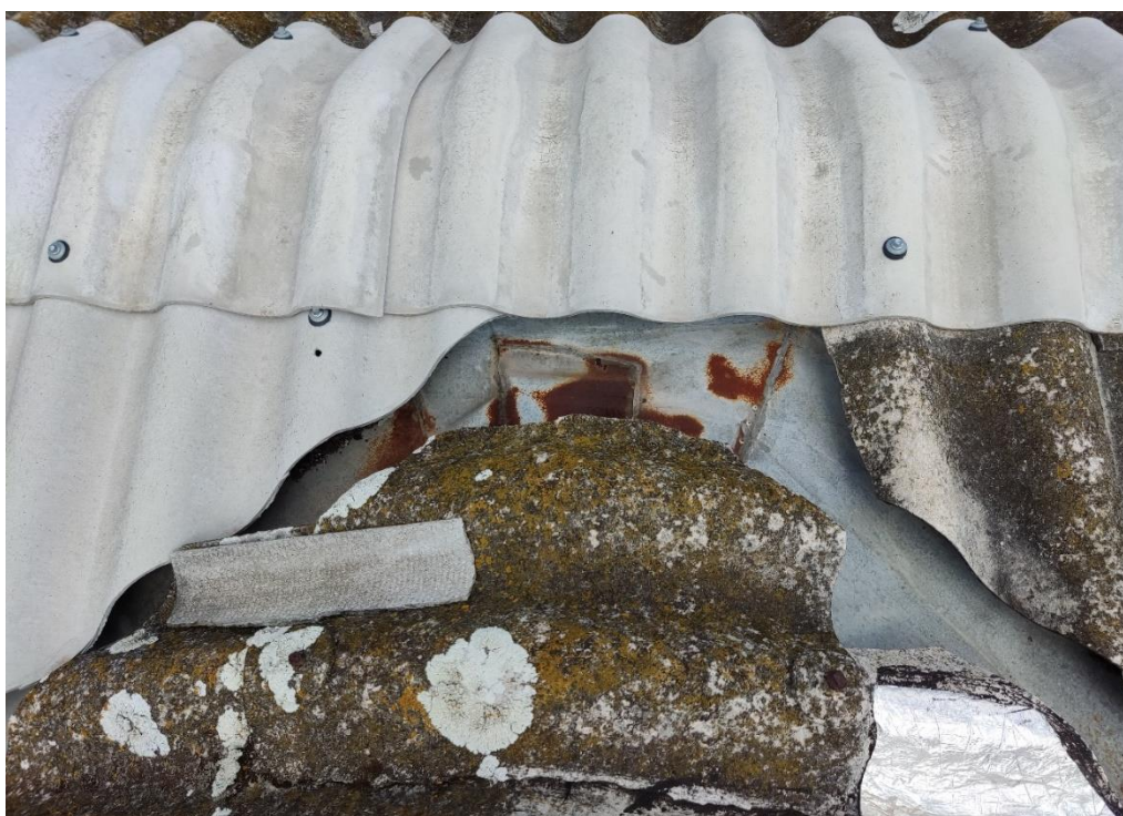
Figura 3 – Telhas completamente quebradas no encontro das águas do telhado (água furtada)
