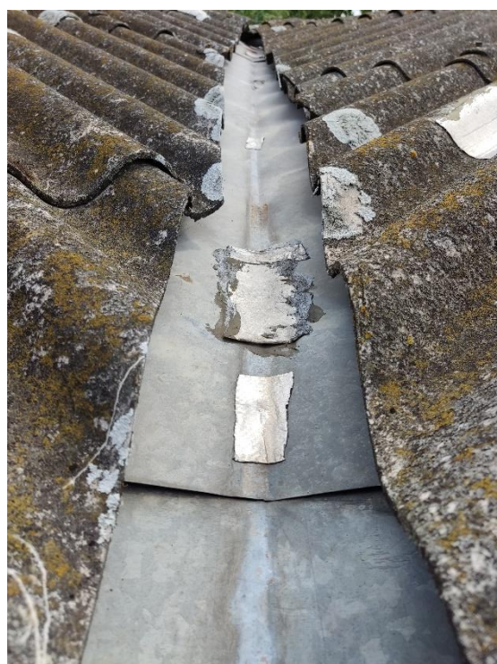
Figura 7 – Calha com pontos de infiltração
