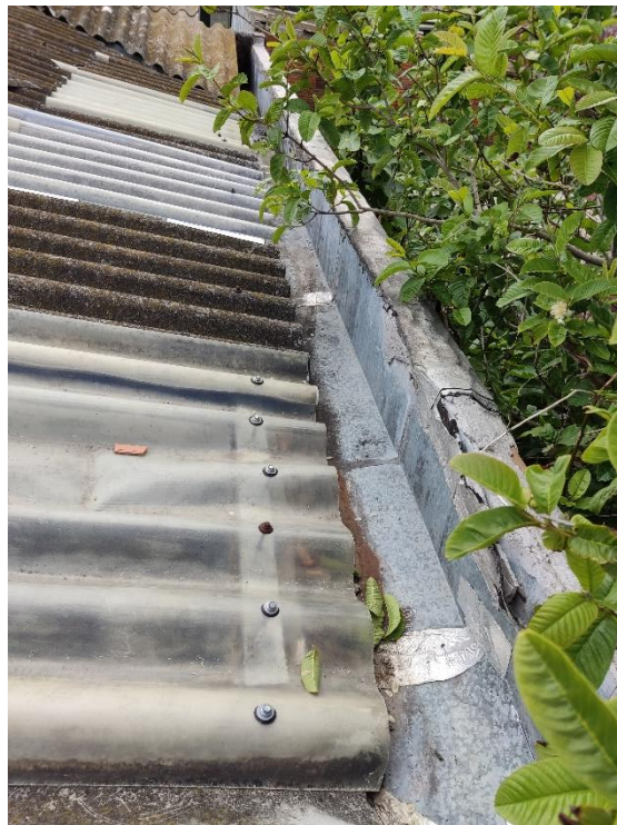
Figura 5 – Calha rasa
