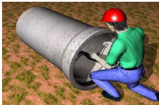
Figura 10- Colocação do anel de borracha
