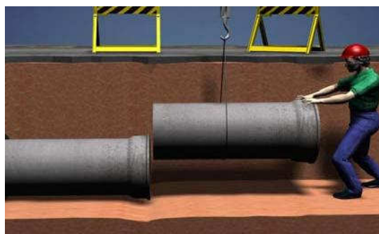
Figura 12– Acoplamento de tubos de concreto
