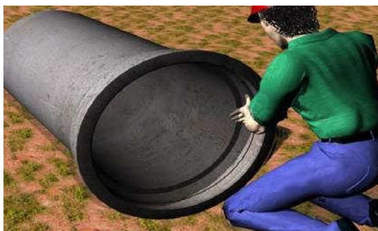
Figura 11 - Lubrificação do anel de borracha
