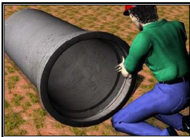
Figura 55 - Lubrificação do anel de borracha
