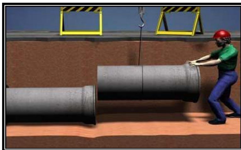
Figura 56 - Acoplamento de tubos de concreto
