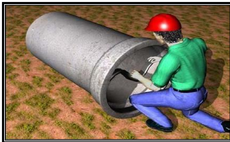
Figura 54 - Colocação do anel de borracha
