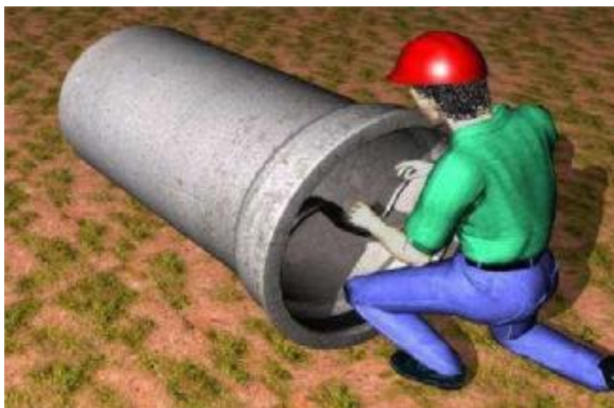
Figura 09- Colocação do anel de borracha
