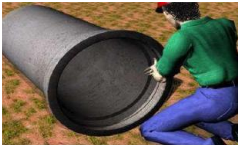
Figura 10 - Lubrificação do anel de borracha
