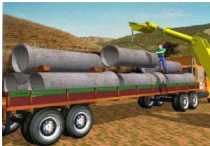
Figura 07. Descarregamento dos tubos
