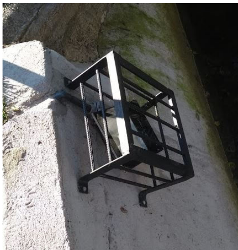
18. REFLETOR EXISTENTE COM GRADE DE FERRO.
