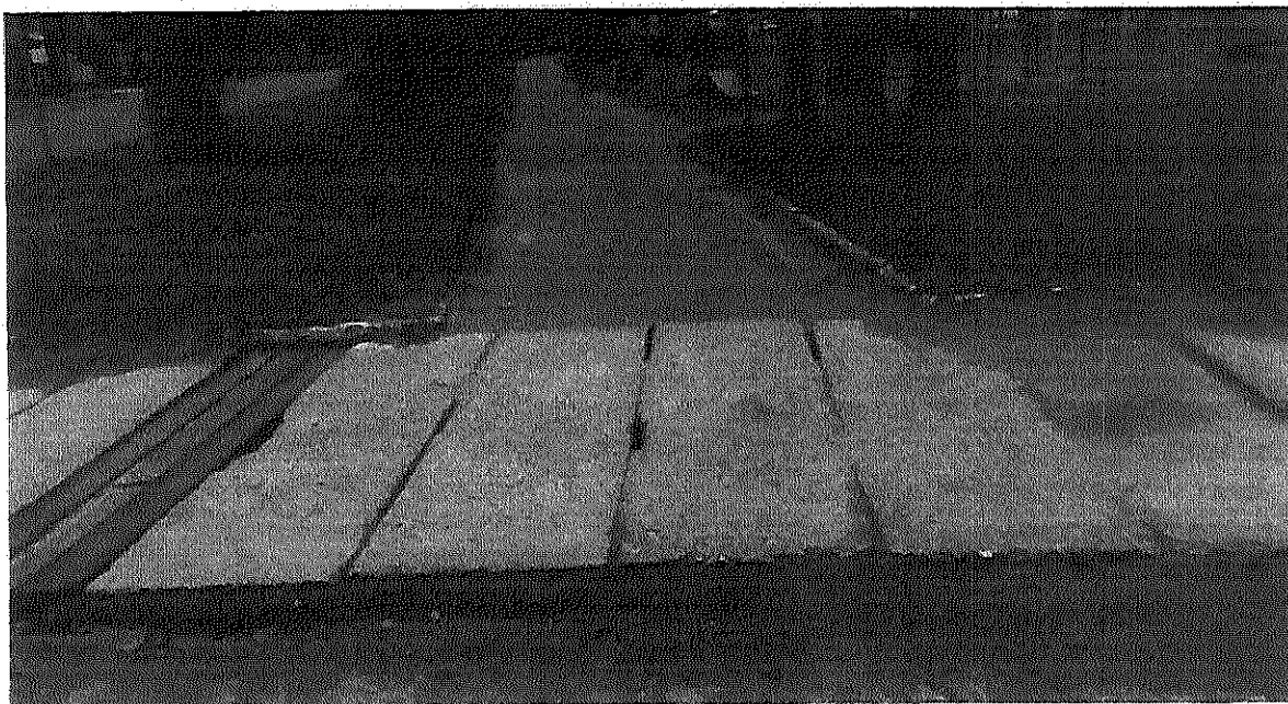
Figura 6 - Travessia da ciclovia sobre a galeria existente na Rua Rio de Janeiro.
