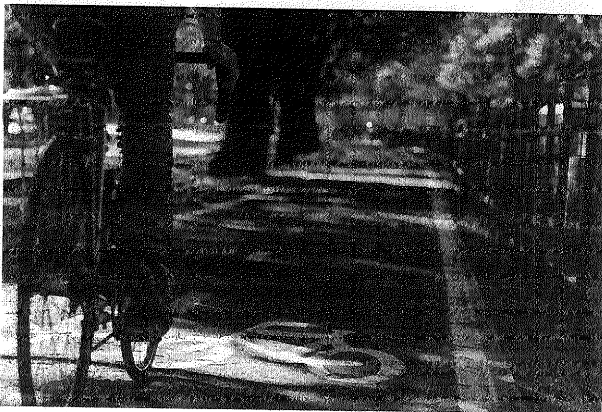
Figura 5 - Exemplo de sinalização horizontal executada na ciclovia da Av. Érico Veríssimo, em Porto Alegre.
