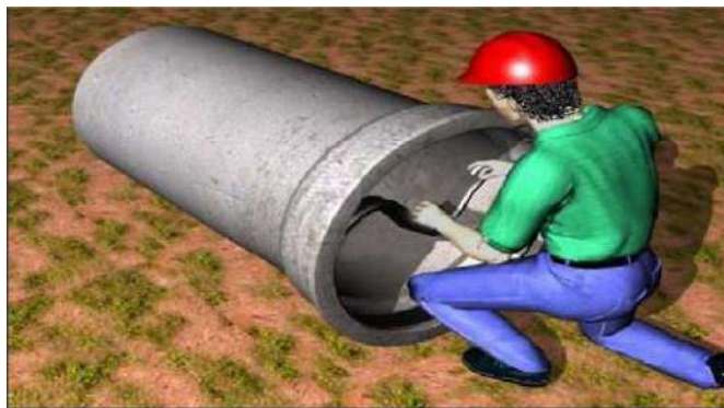
Figura 16 - Colocação do anel de borracha
