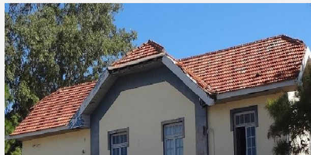
figura 03 – detalhe telhas cerâmicas a ser retirada
