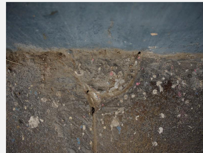
figura 07 - resquício de uma das caixas de inspeção antiga a ser recuperada
