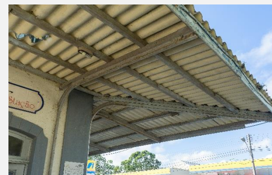
figura 02 – detalhe da estrutura de madeira a ser retirada
