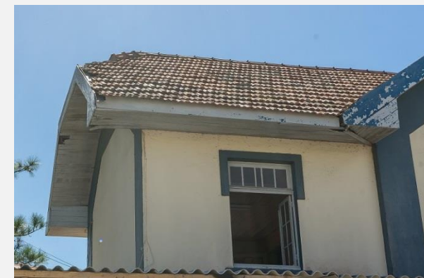
figura 04 – detalhe beiral de madeira a ser recuperado
