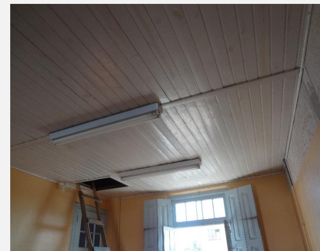
figura 09 - detalhe do forro de madeira a ser substituído
