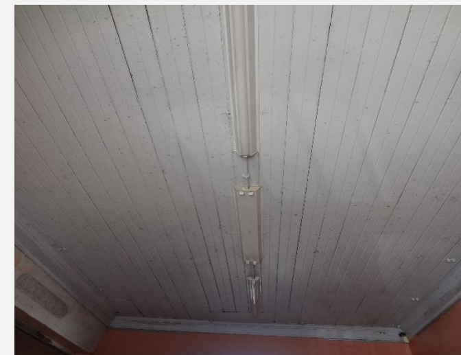
figura 08 - detalhe do forro de madeira a ser restaurado
