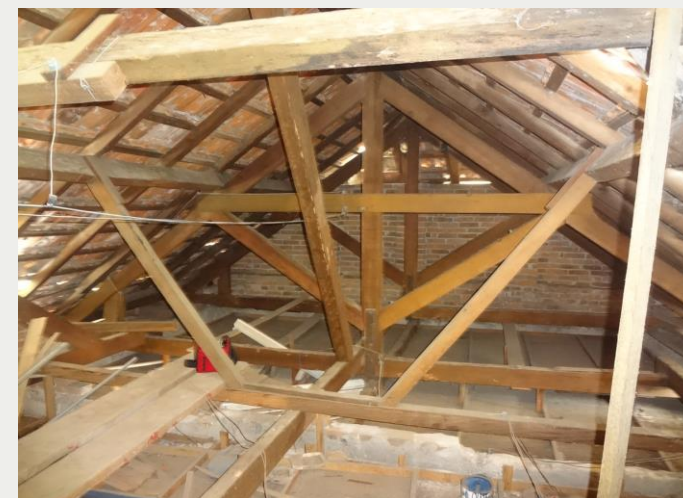
Imagem 03: Estrutura em madeira da cobertura principal. Fonte: Equipe SNA, 2018.
