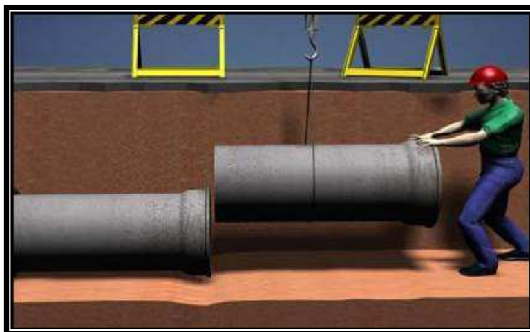
Figura 18 – Acoplamento de tubos de concreto
