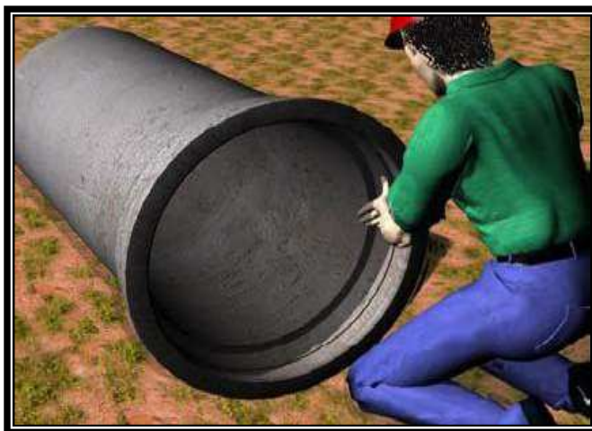
Figura 17 - Lubrificação do anel de borracha
