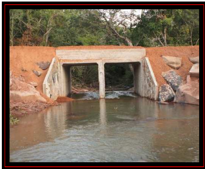
Figura 16: Ala com 2 células de concreto
