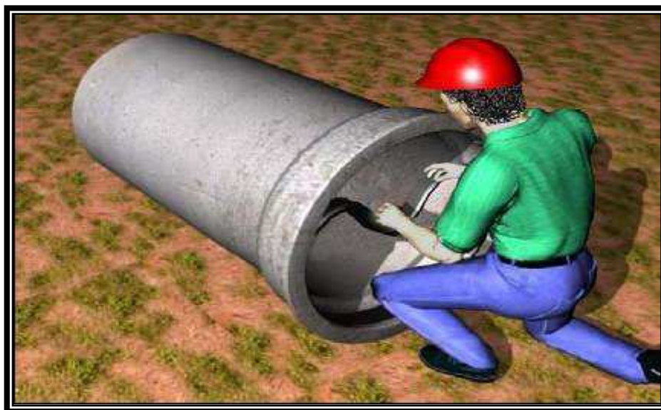
Figura 11- Colocação do anel de borracha
