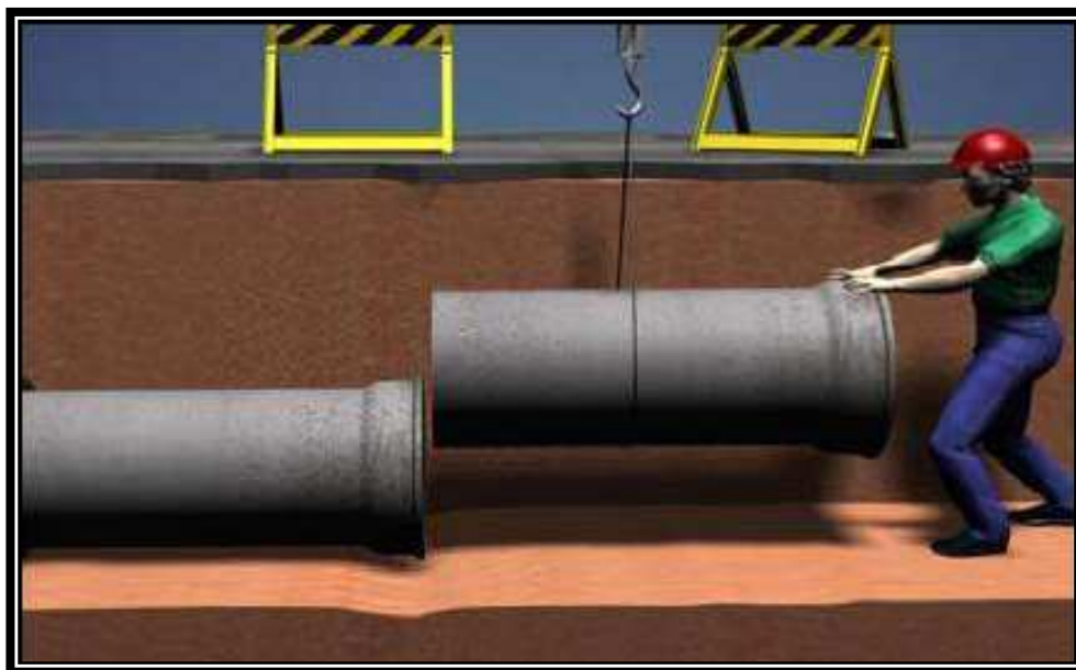
Figura 13– Acoplamento de tubos de concreto
