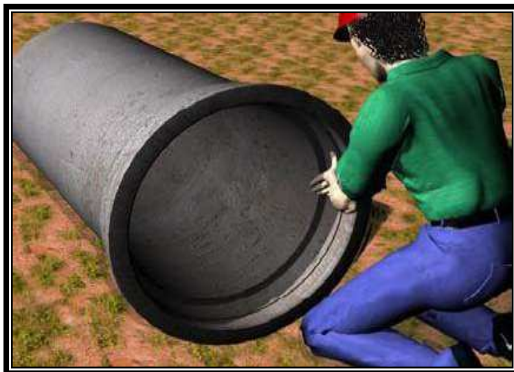
Figura 12 - Lubrificação do anel de borracha
