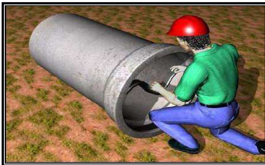
Figura 11- Colocação do anel de borracha
