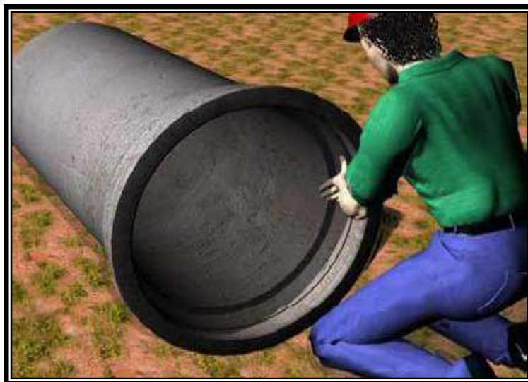
Figura 12 - Lubrificação do anel de borracha
