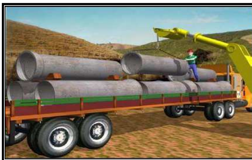
Figura 9. Descarregamento dos tubos
