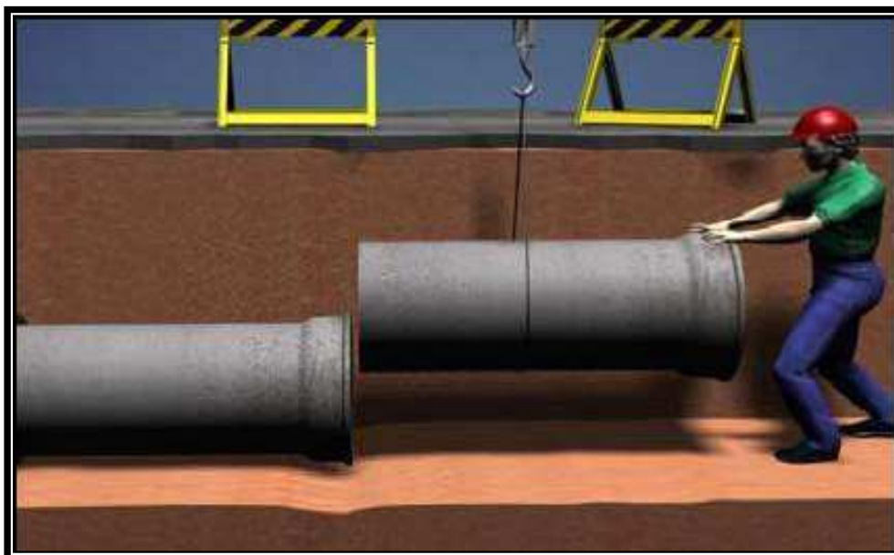
Figura 13– Acoplamento de tubos de concreto
