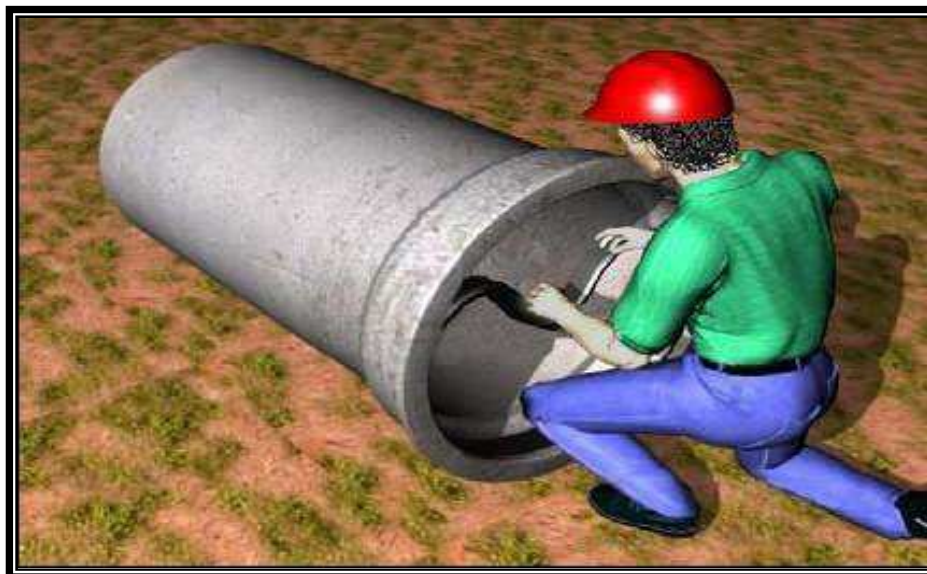
Figura 11- Colocação do anel de borracha
