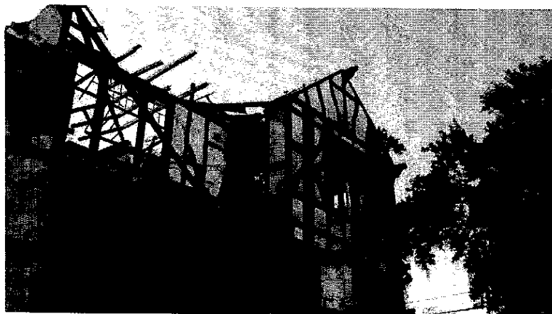
Foto 09: fachada principal com problemas no escoramento, colocar escoras de 11m, conforme detalhe.
