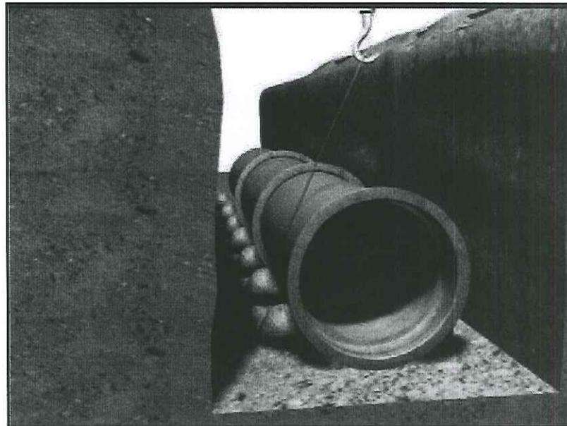
Figura 15 – Alinhamento dos tubos com uso de calços
