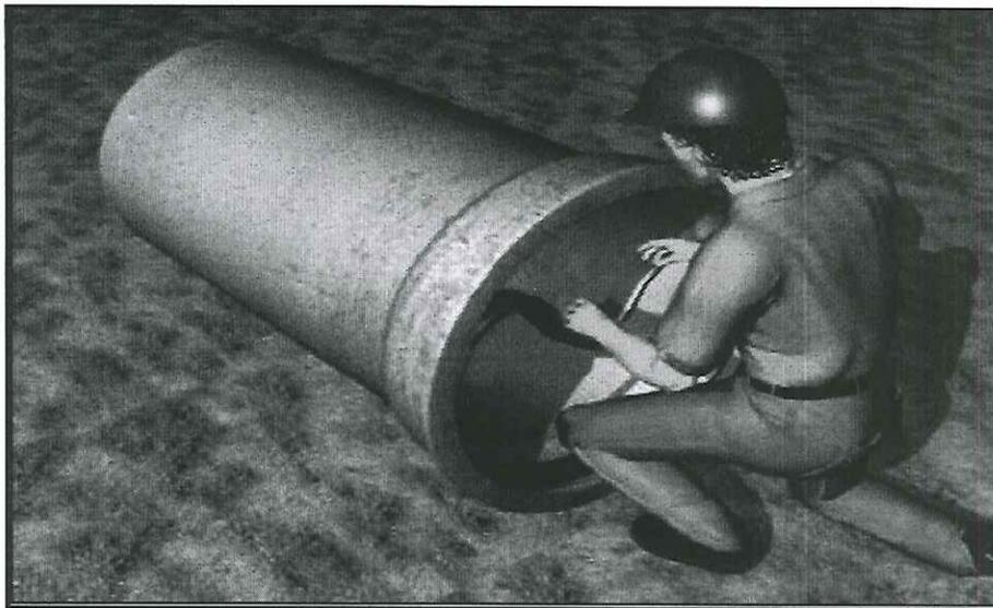
Figura 12 - Colocação do anel de borracha
