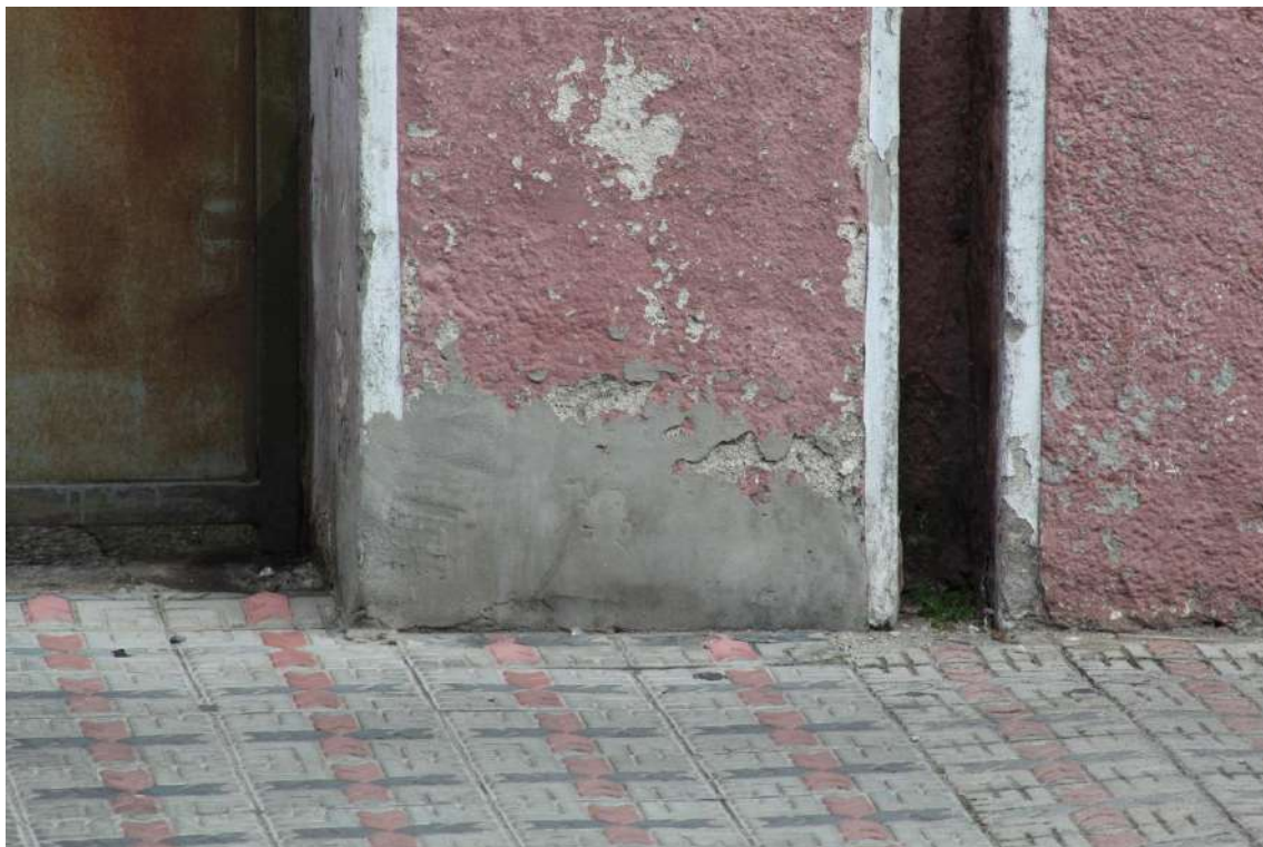
FACHADA NORTE: conserto com reboco de argamassa de cimento | descascamento da pintura
