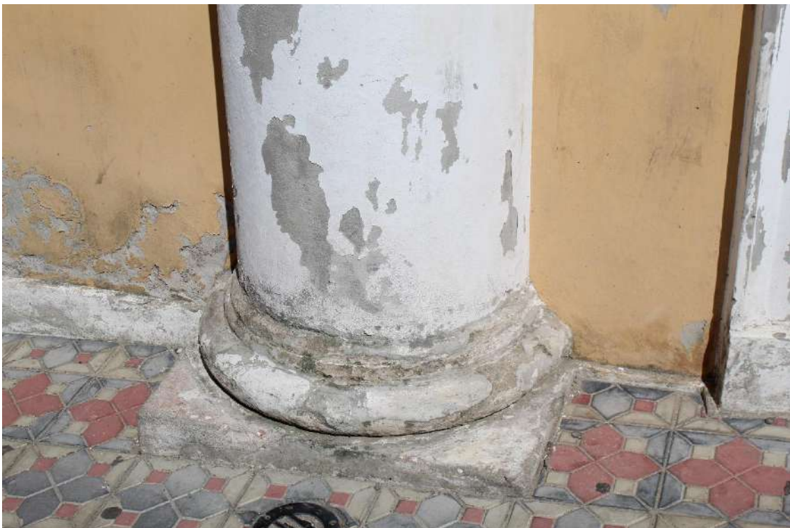
FIGURA 12 = FACHADA NORDESTE: base do pilar e parte inferior da parede com reboco danificado
