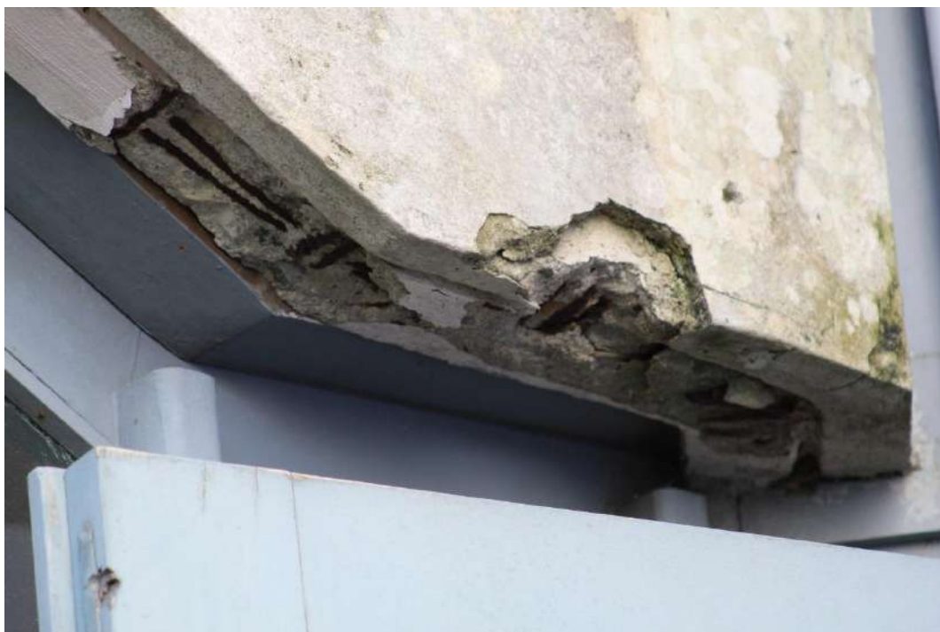
Viga "sudeste" da laje de cobertura do primeiro lance da escada (externo)
