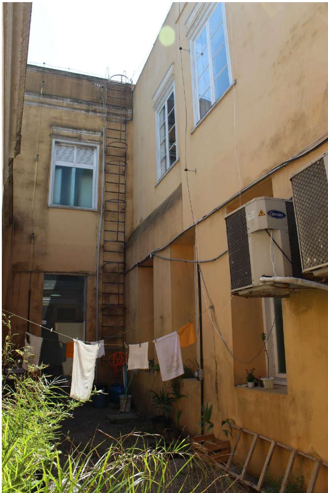
FIGURA 30 = PÁTIO INTERNO: visão geral
