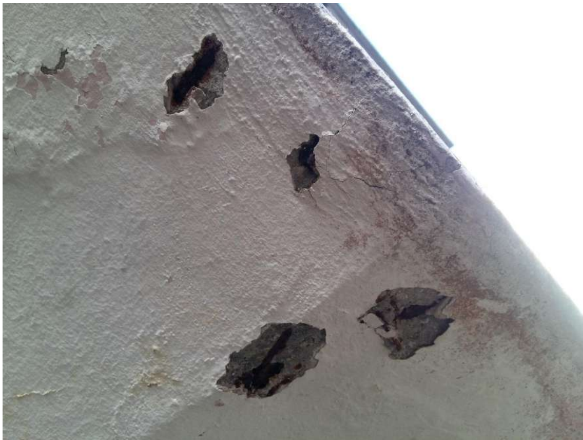
Laje de piso (externo), entre primeiro patamar e segundo lance (externo)
