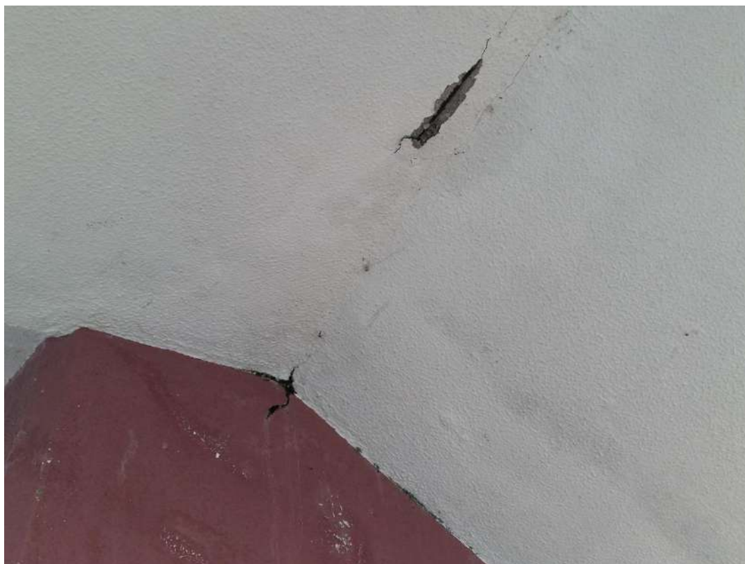
Laje de cobertura entre segundo lance e segundo patamar (interno)
