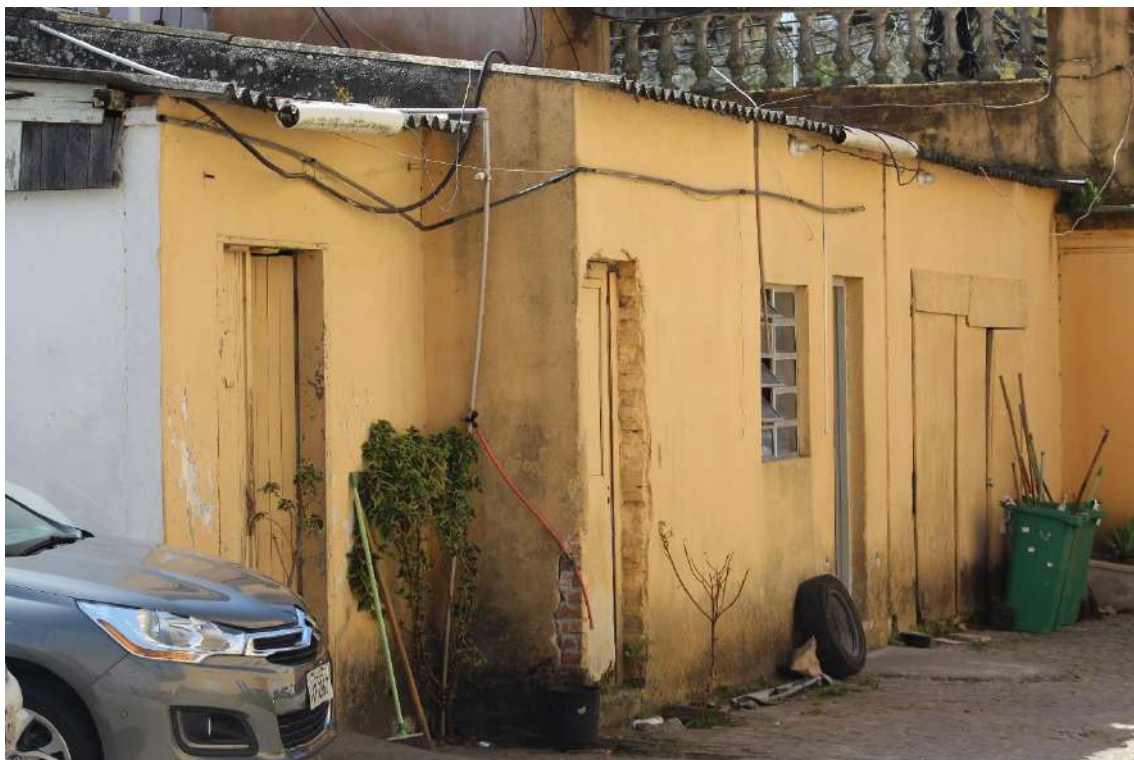
FIGURA 28 = PÁTIO LATERAL: construções modernas que podem ser recuperadas com argamassa de cimento, cal e areia
