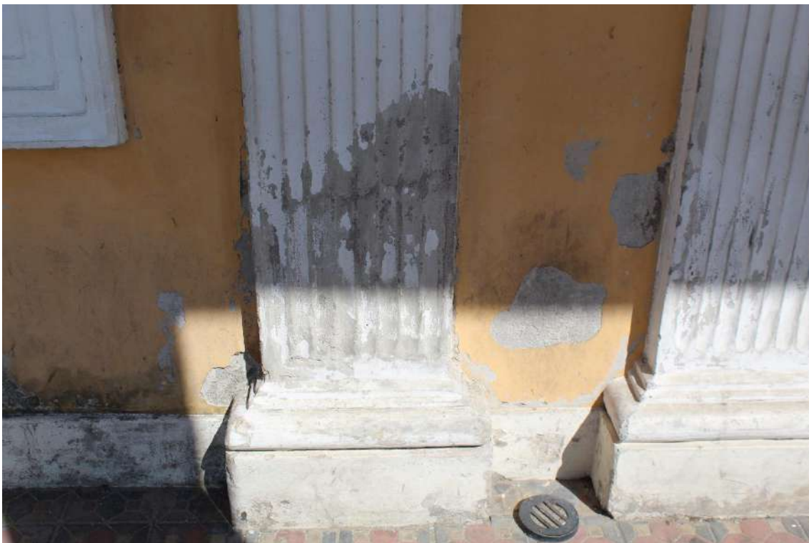
FIGURA 17 = FACHADA NORDESTE: deslocamento do reboco da parede e pilares
