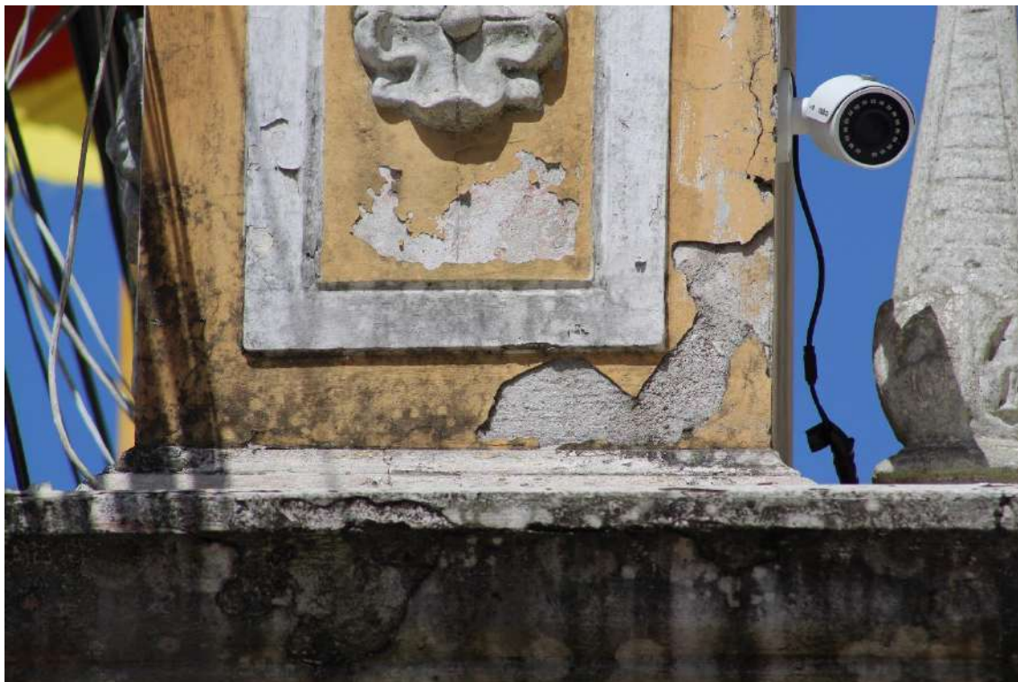
FIGURA 09 = FACHADA NORDESTE: pontos de deslocamento do reboco do parlatório.
