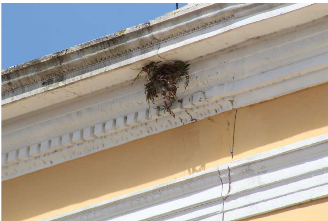
FIGURA 26 = FACHADA NOROESTE: vegetação a ser removida
