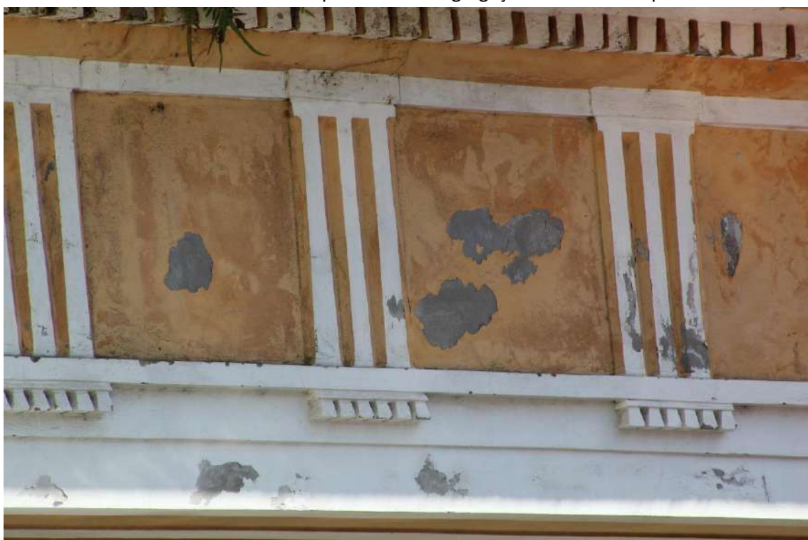
FIGURA 06 = FACHADA NORDESTE: pontos de desagregação do reboco do parlatório.
