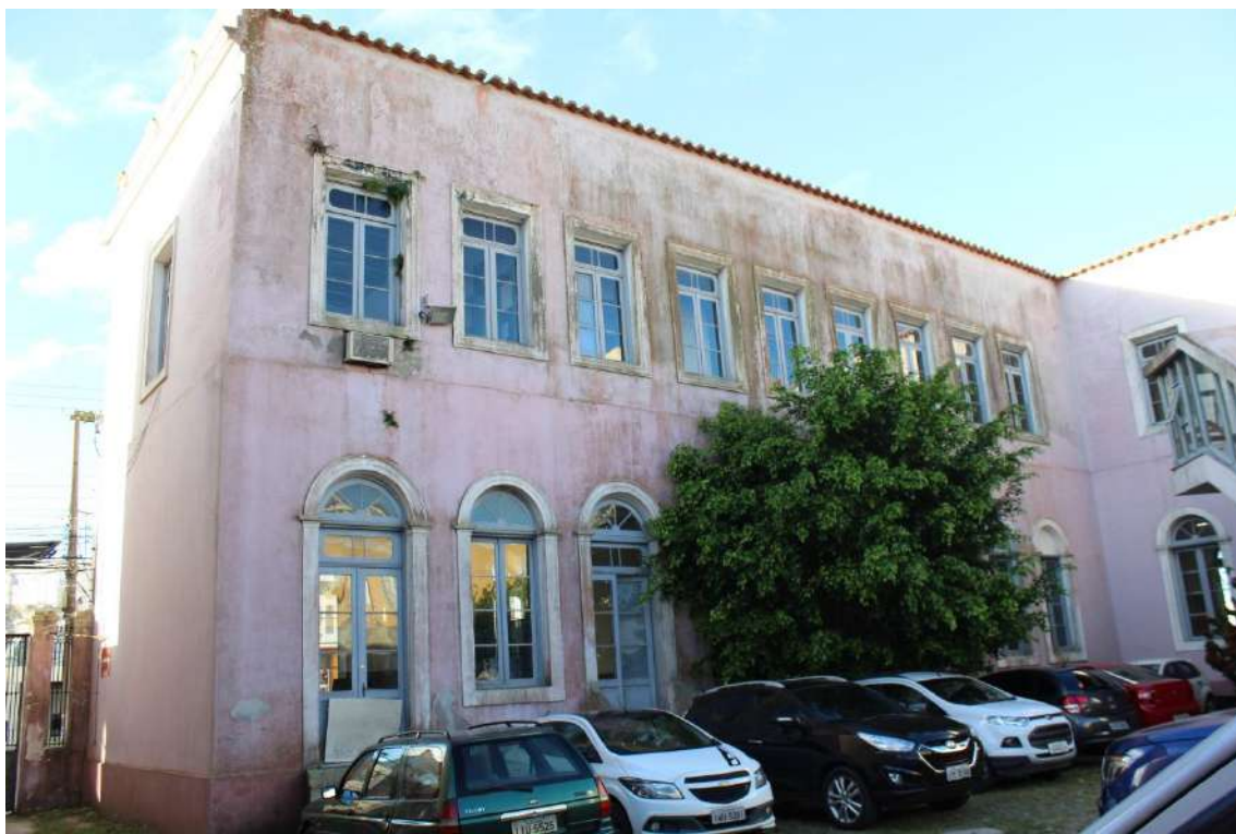
FACHADA SUL: visão geral | árvore da espécie Ficus bejamina que deve ser removida em função de suas raízes agressivas ameaçarem a estrutura da edificação
