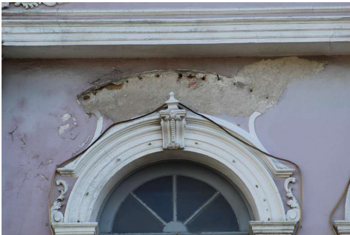
FACHADA LESTE: fissuras superficiais diversas nos revestimentos | cordão de iluminação decorativa | fixadores de fios
