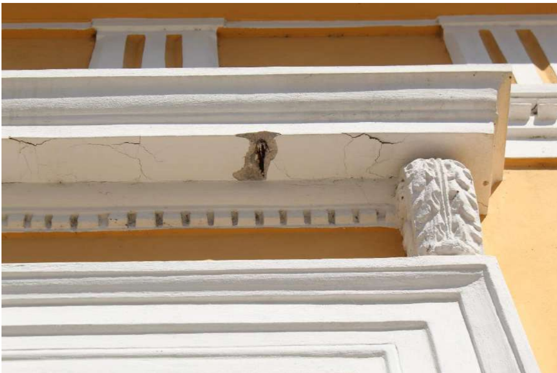
FIGURA 16 = FACHADA NORDESTE: armadura do ornamento exposta, em processo de oxidação
