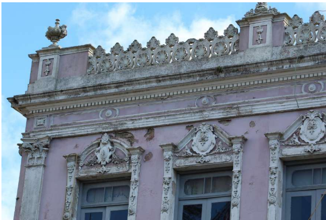
FACHADA LESTE: visão geral
