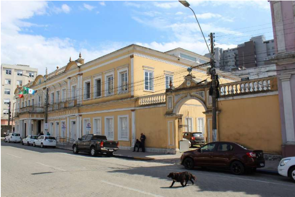
FIGURA 01 = FACHADA NORDESTE: visão geral
