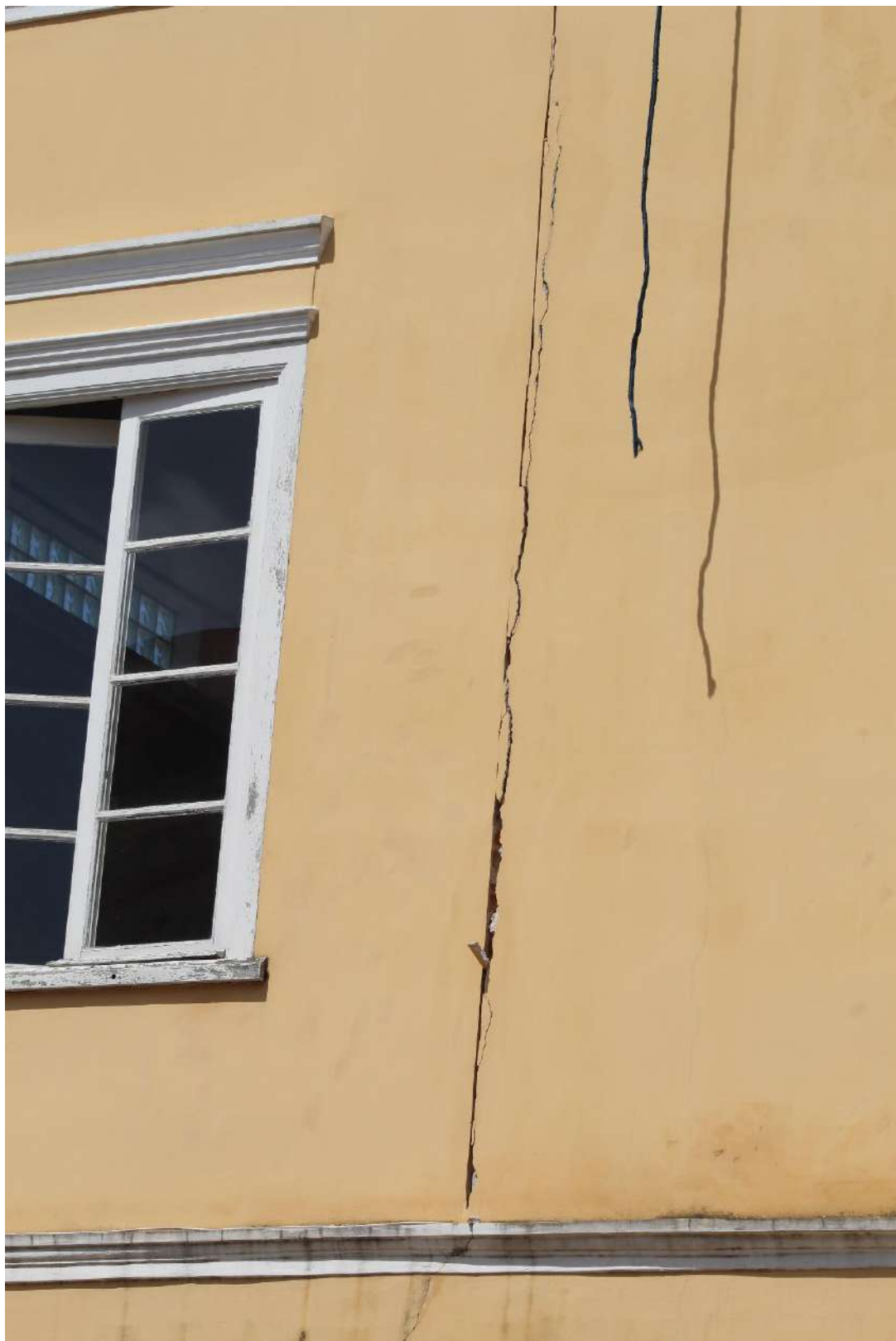
FIGURA 27 = FACHADA NOROESTE: ponto de união entre as alvenarias executadas em épocas diferentes, que deve receber tratamento específico para junta de dilatação
