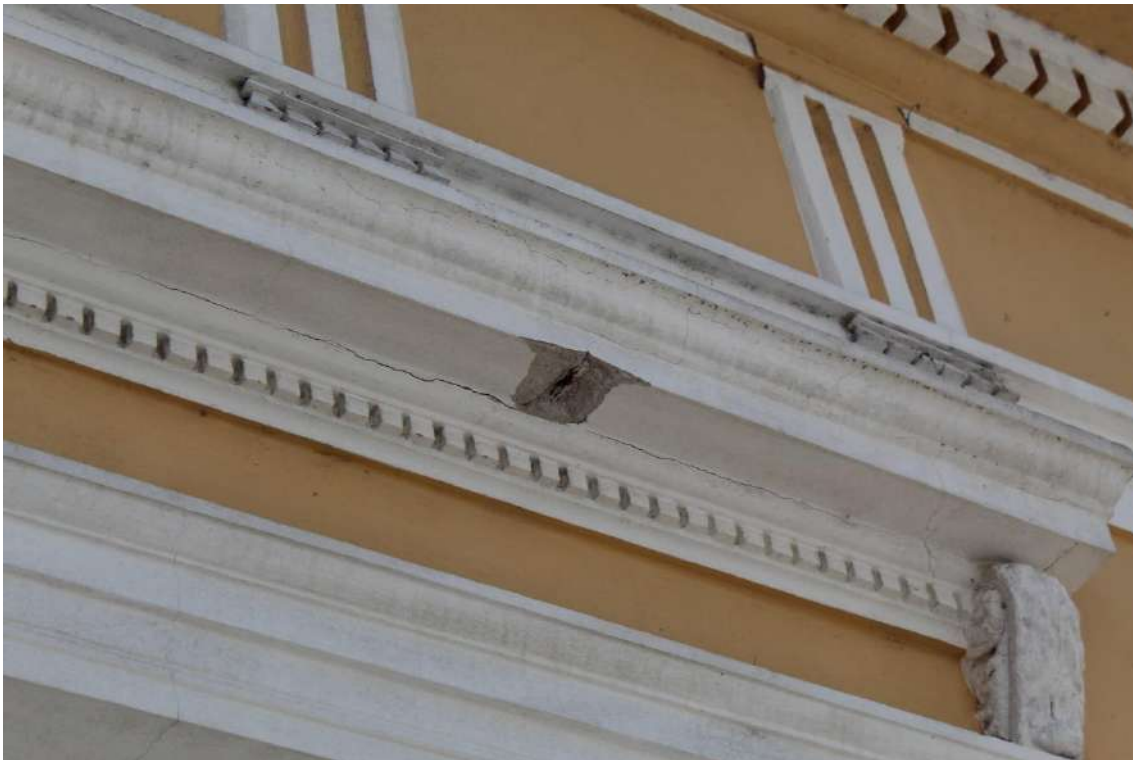
FIGURA 21 = FACHADA SUDESTE: armadura do ornamento exposta, em processo de oxidação
