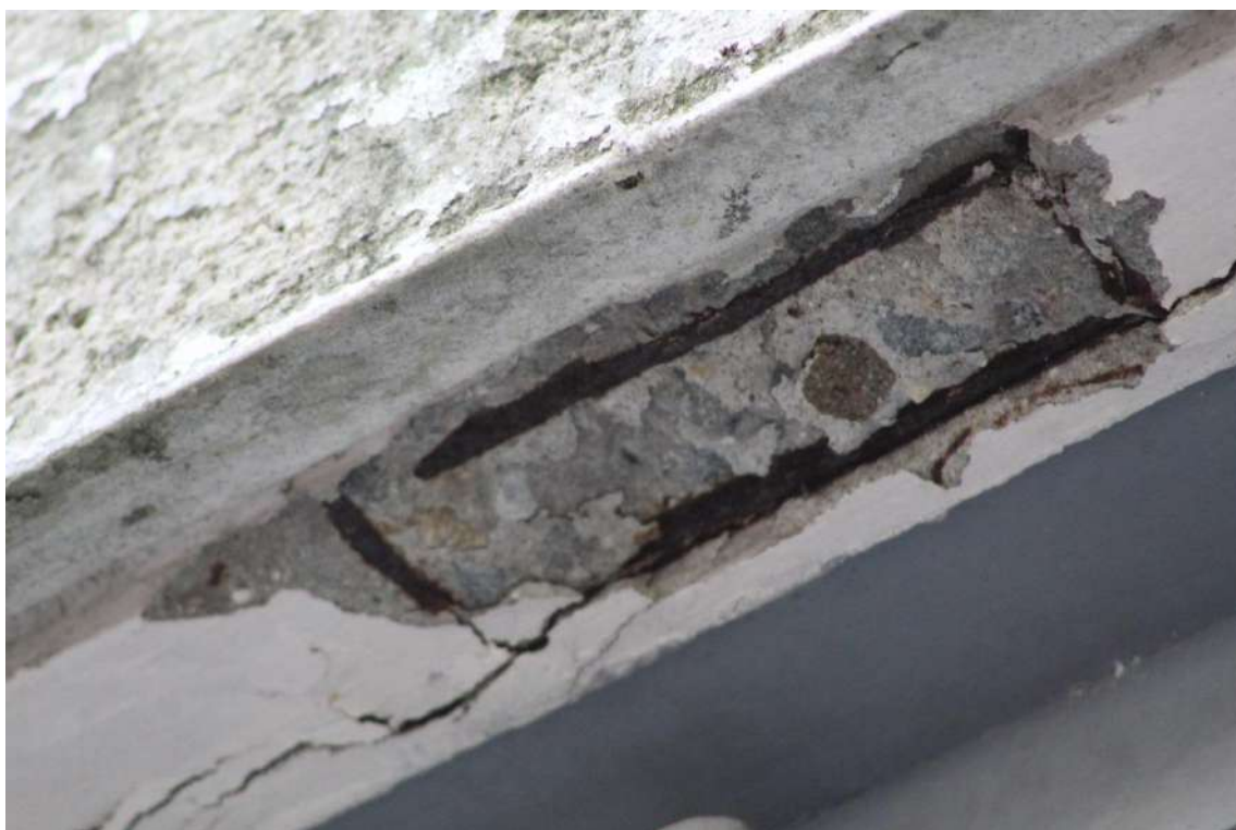
Viga “sudoeste” da laje de cobertura do primeiro patamar da escada (externo)
