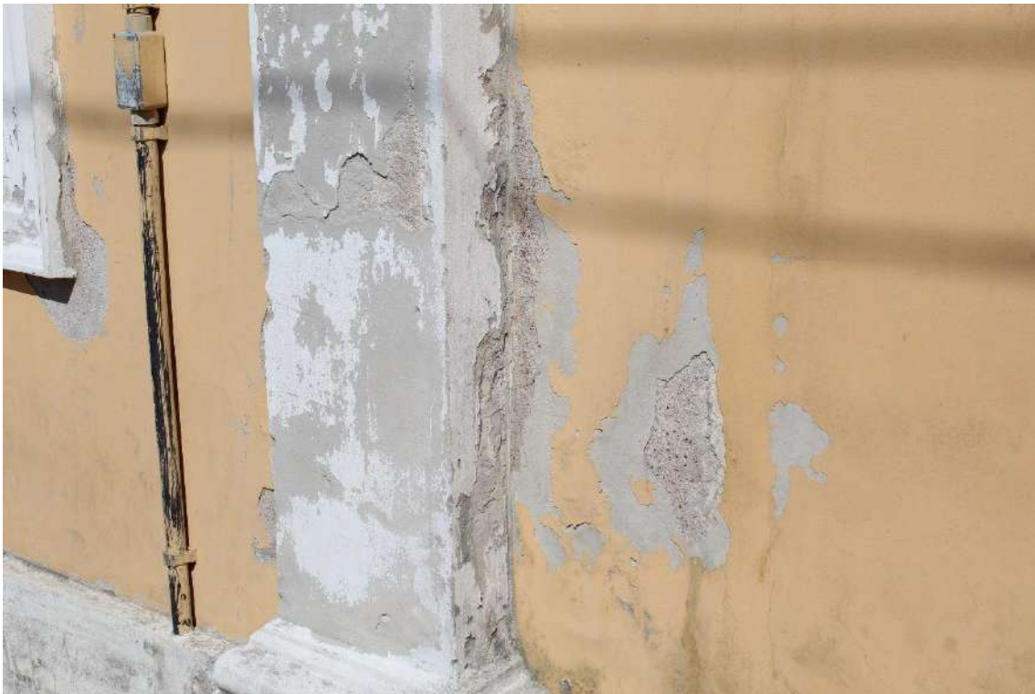
FIGURA 13 = FACHADA NORDESTE: reboco do pilar e da parede danificados
