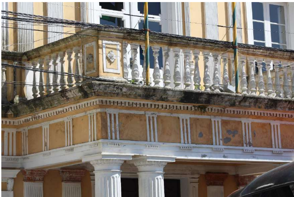
FIGURA 05 = FACHADA NORDESTE: pontos de desagregação do reboco do parlatório.
