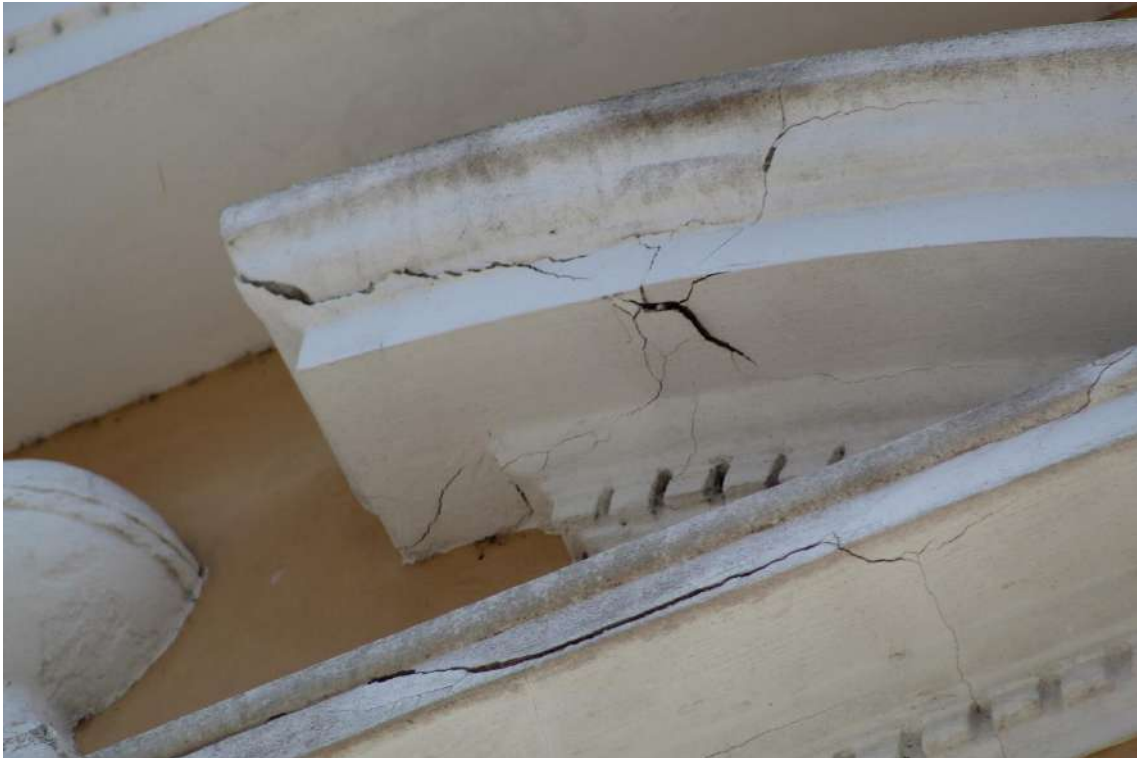
FIGURA 03 = FACHADA NORDESTE: fissuras no ornamento a serem avaliadas.
