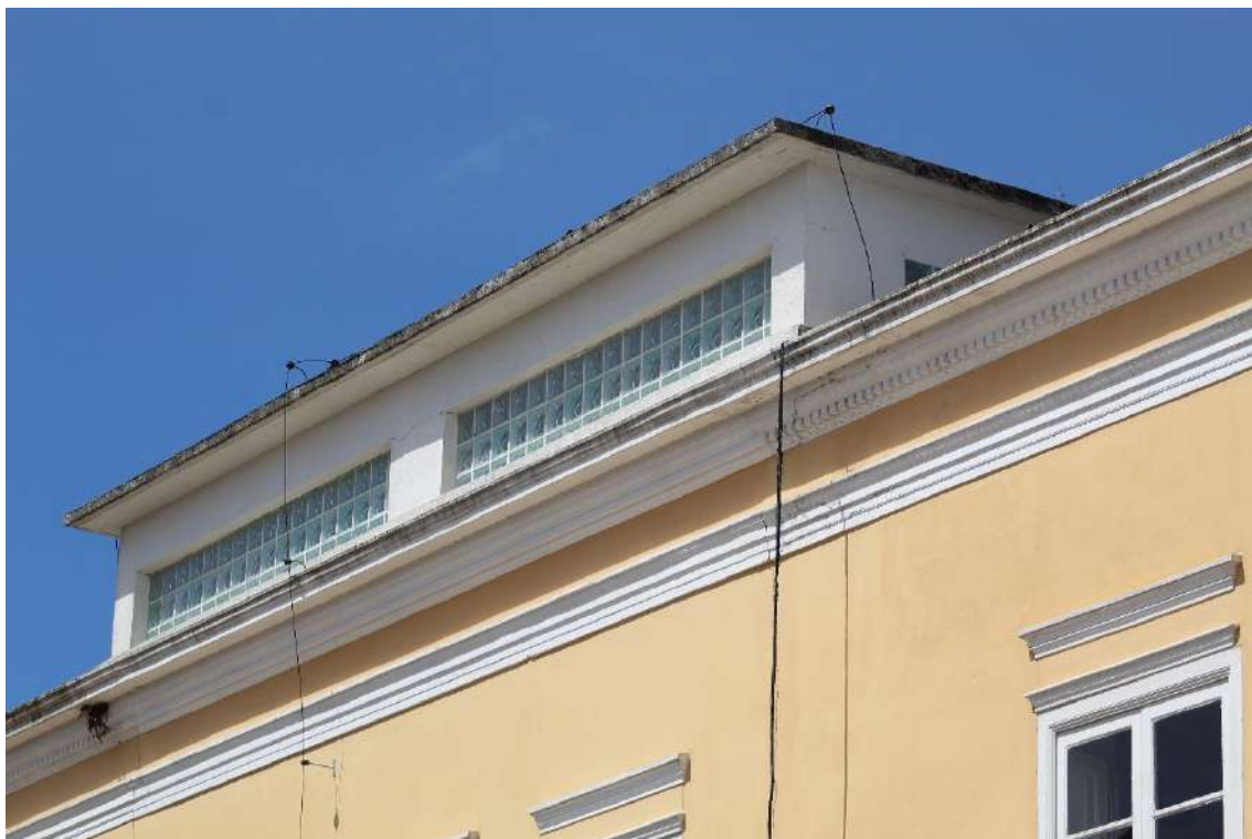
FIGURA 25 = FACHADA NOROESTE: trecho central da fachada com fissuras na união das alvenarias construídas em épocas diferentes.
