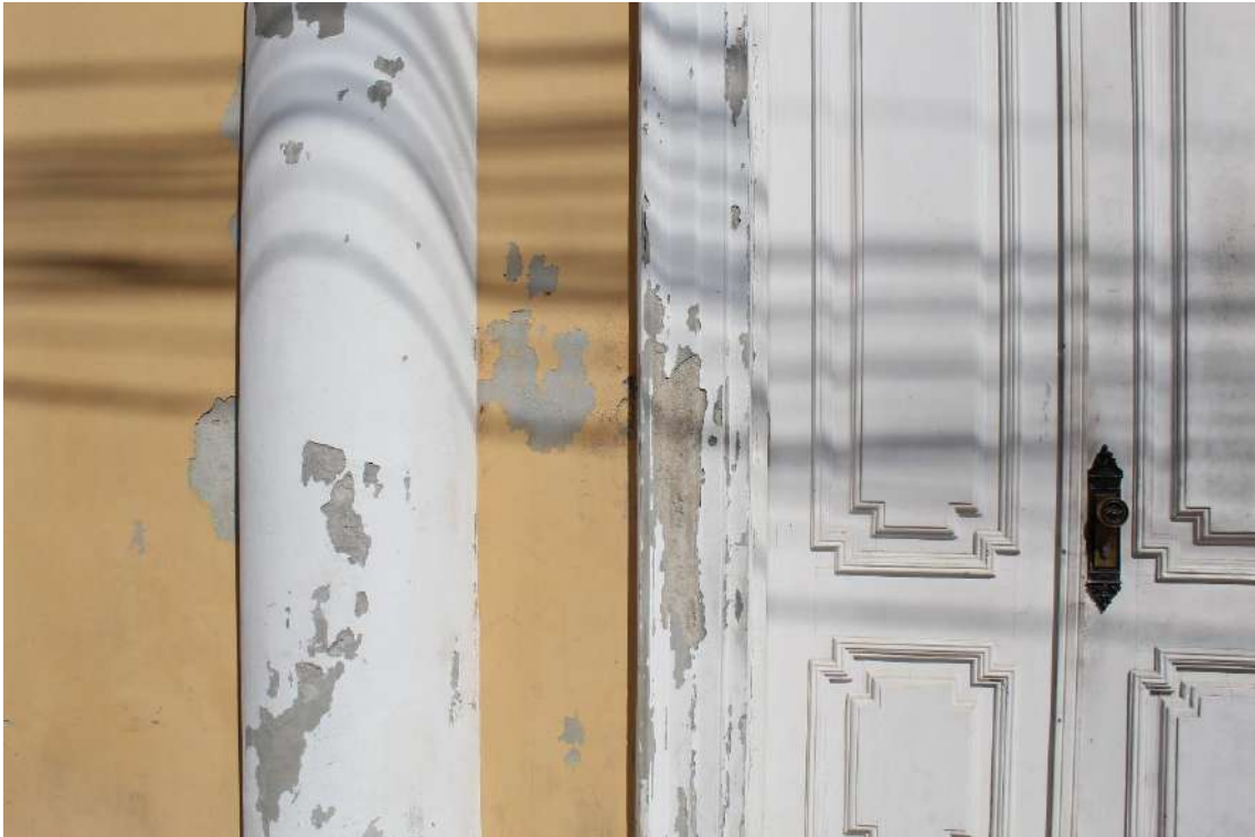
FIGURA 11 = FACHADA NORDESTE: descascamento da pintura e descolamento do reboco
