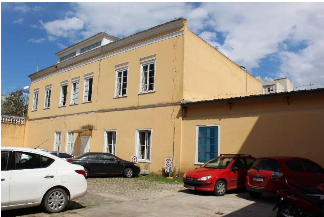
FIGURA 24 = FACHADA NOROESTE: visão geral
