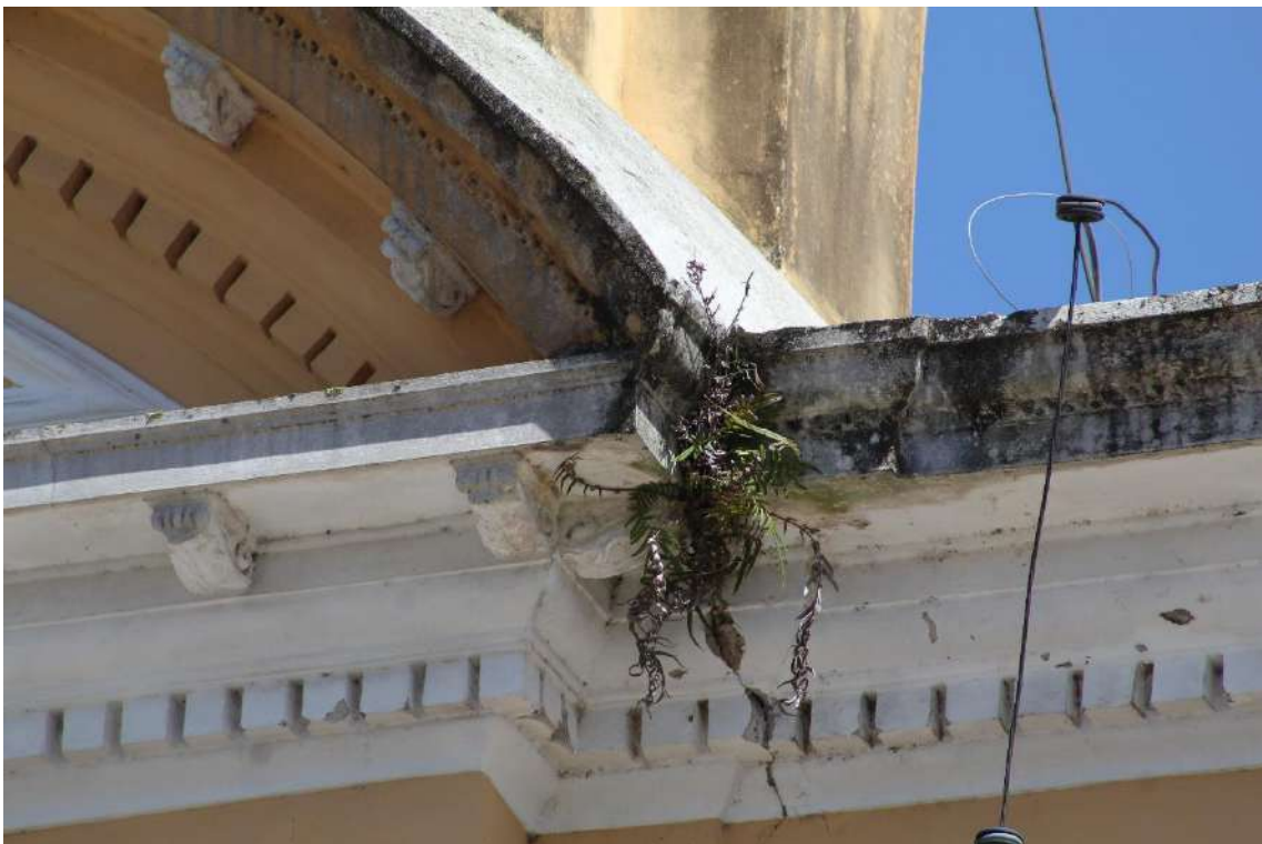
FIGURA 02 = FACHADA NORDESTE: vegetação a ser removida
