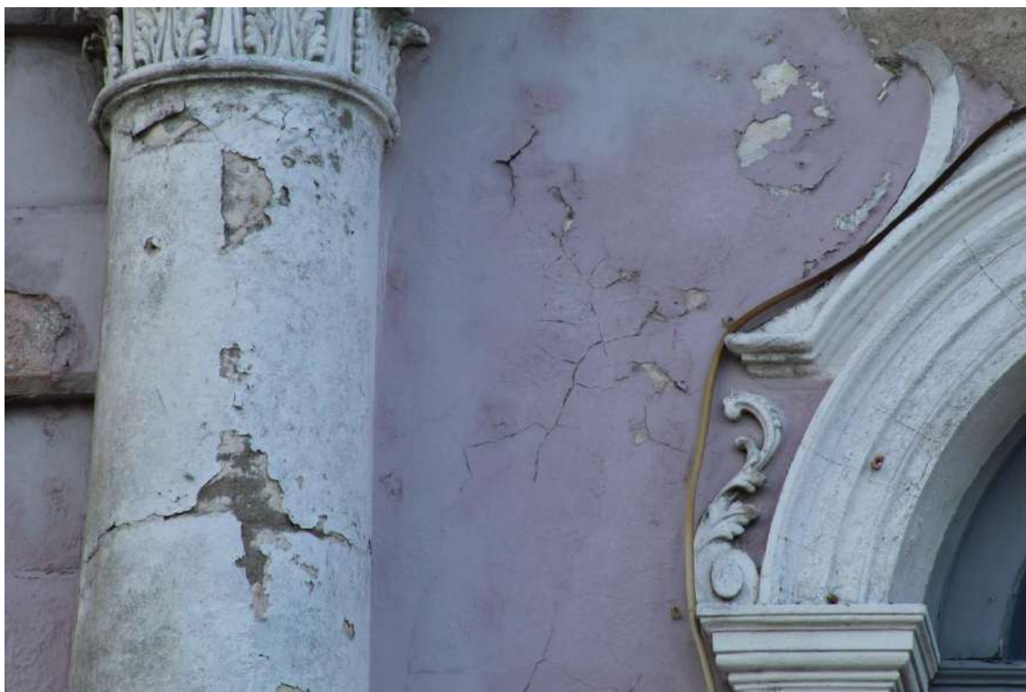
FACHADA LESTE: fissuras superficiais diversas nos revestimentos | cordão de iluminação decorativa | fixadores de fios
