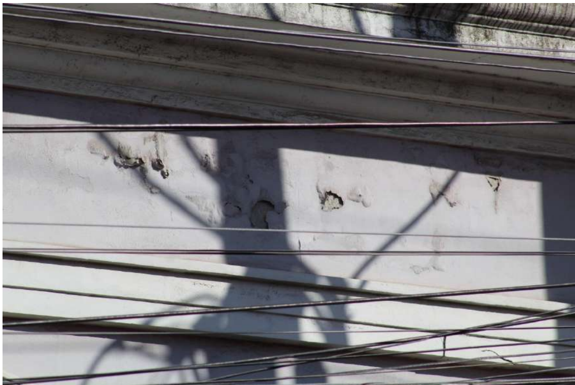
FACHADA NORTE: conserto com reboco de argamassa de cimento | descascamento da pintura
