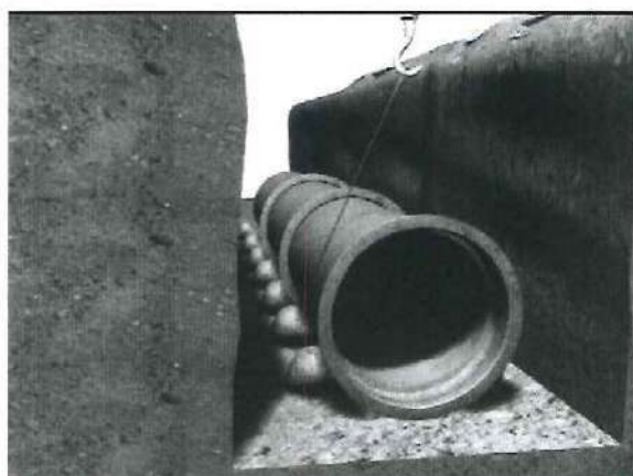
Figura 11 – Alinhamento dos tubos com uso de calços
