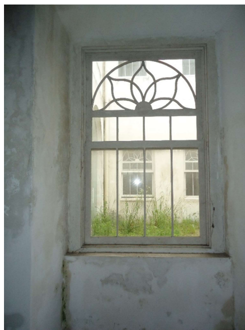
Figura 7: Janela tipo guilhotina existente, instalar levantadores concha mais suportes borboletas.
