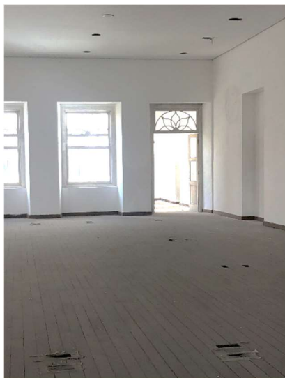
Figura 16: pontos de iluminação no teto e tomadas no piso já locados.
