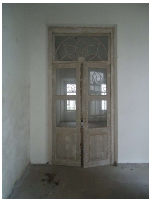
Figura 6: Porta dupla existente, revisar dobradiças e instalar fechadura com roseta.
