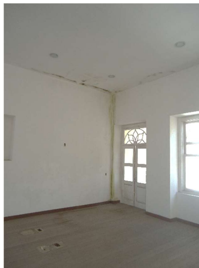
Figura 17: pontos de iluminação no teto e tomadas no piso já locados.
