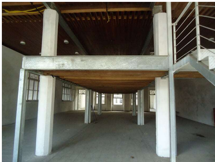
Figura 10: detalhe do mezanino onde deve ser instalado o guarda corpo.
