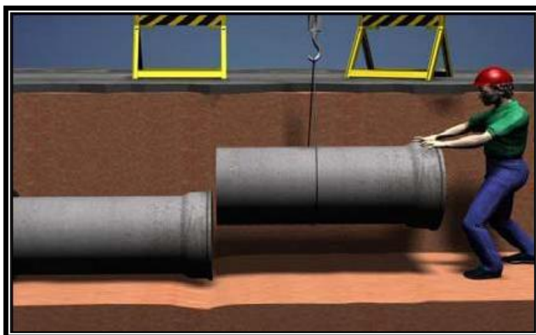
Figura 19 – Acoplamento de tubos de concreto
