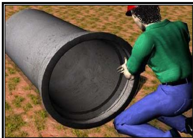
Figura 18 - Lubrificação do anel de borracha
