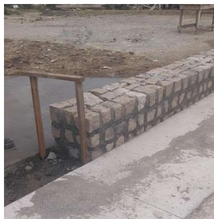
Figura 13: modelo de banco de paralelepípedo sendo executado.
