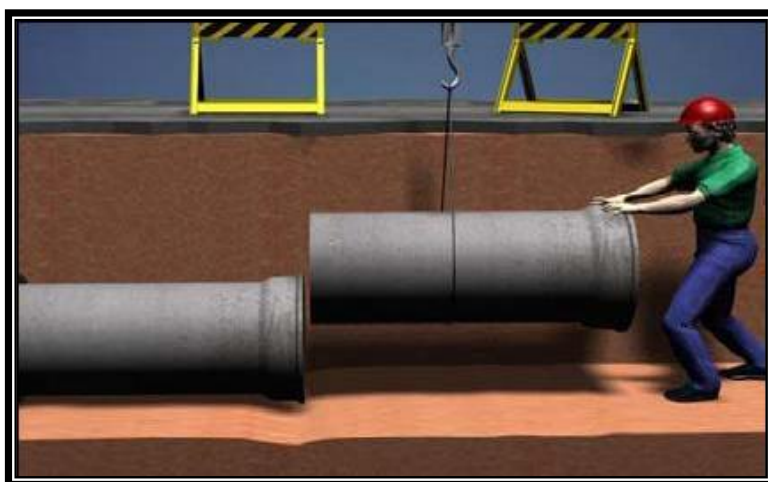
Figura 19 – Acoplamento de tubos de concreto
