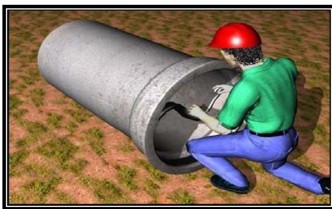
Figura 17 - Colocação do anel de borracha
