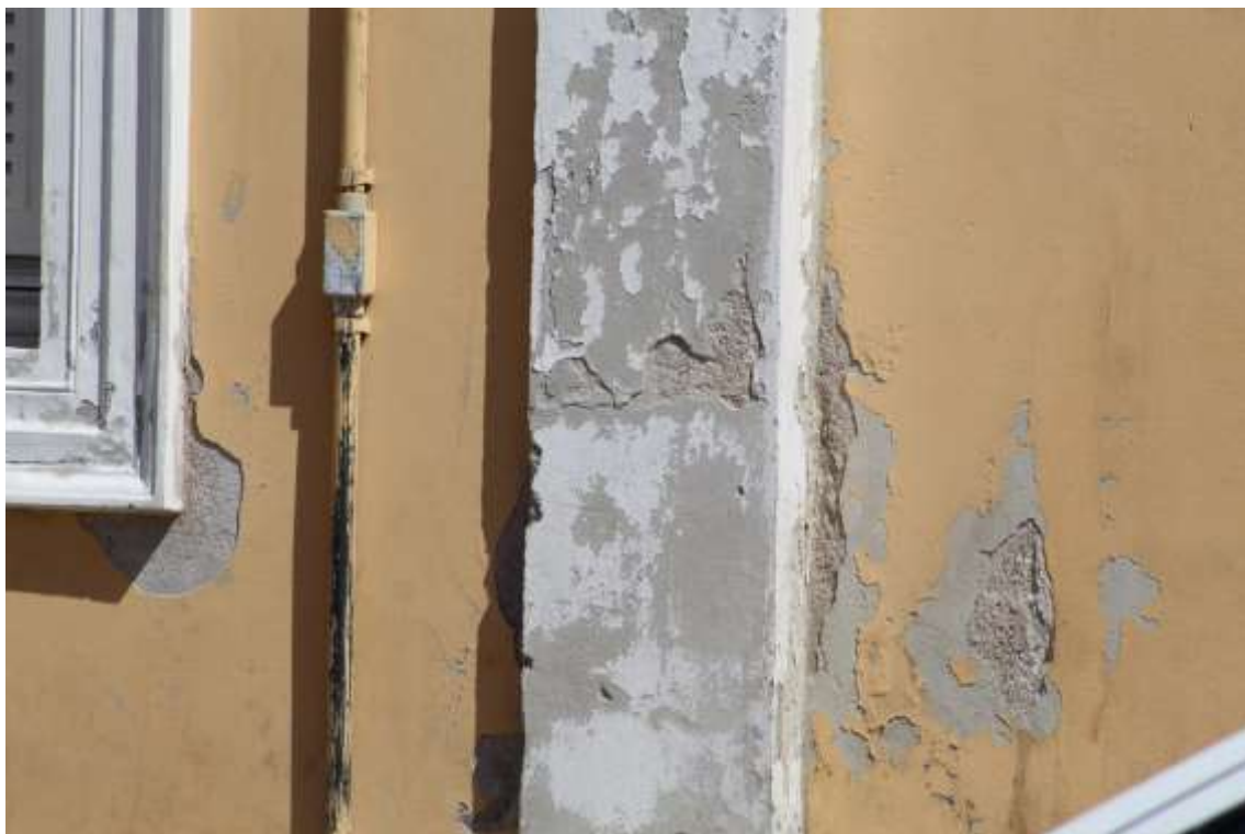
FIGURA 04 = FACHADA NORDESTE: pontos de deslocamento do reboco.
