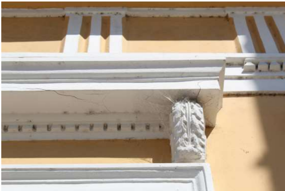
FIGURA 15 = FACHADA NORDESTE: fissuras na argamassa do ornamento
