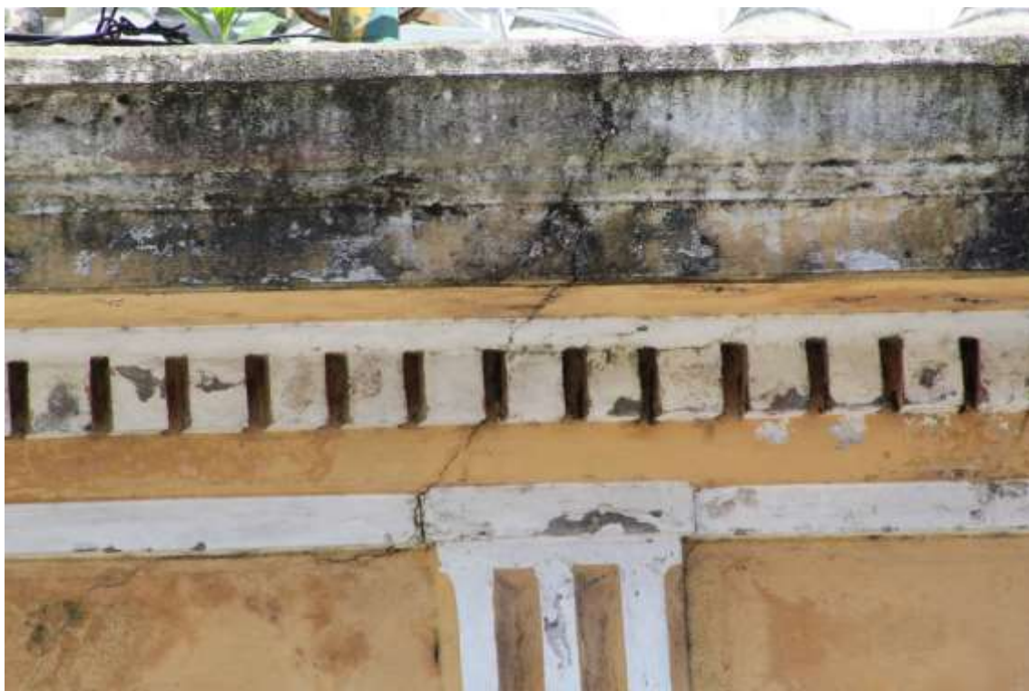
FIGURA 08 = FACHADA NORDESTE: fissura no reboco do parlatório.
