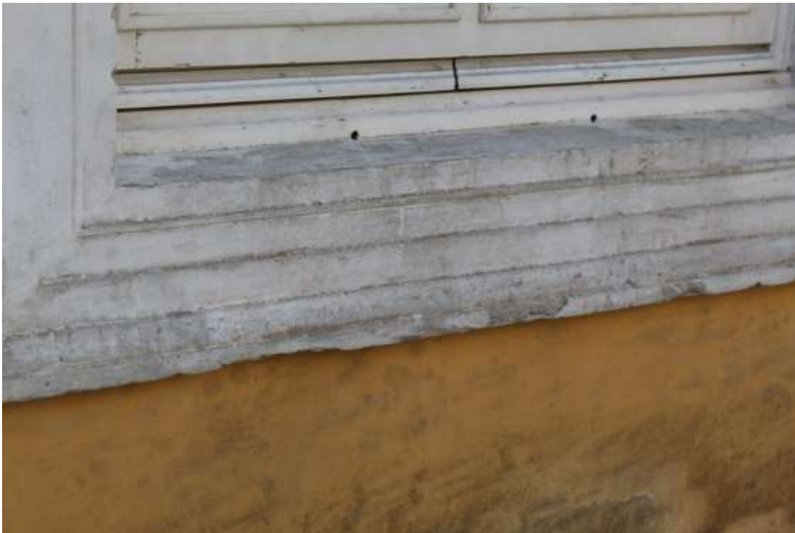
FIGURA 23 = FACHADA SUDESTE: moldura de argamassa avariada
