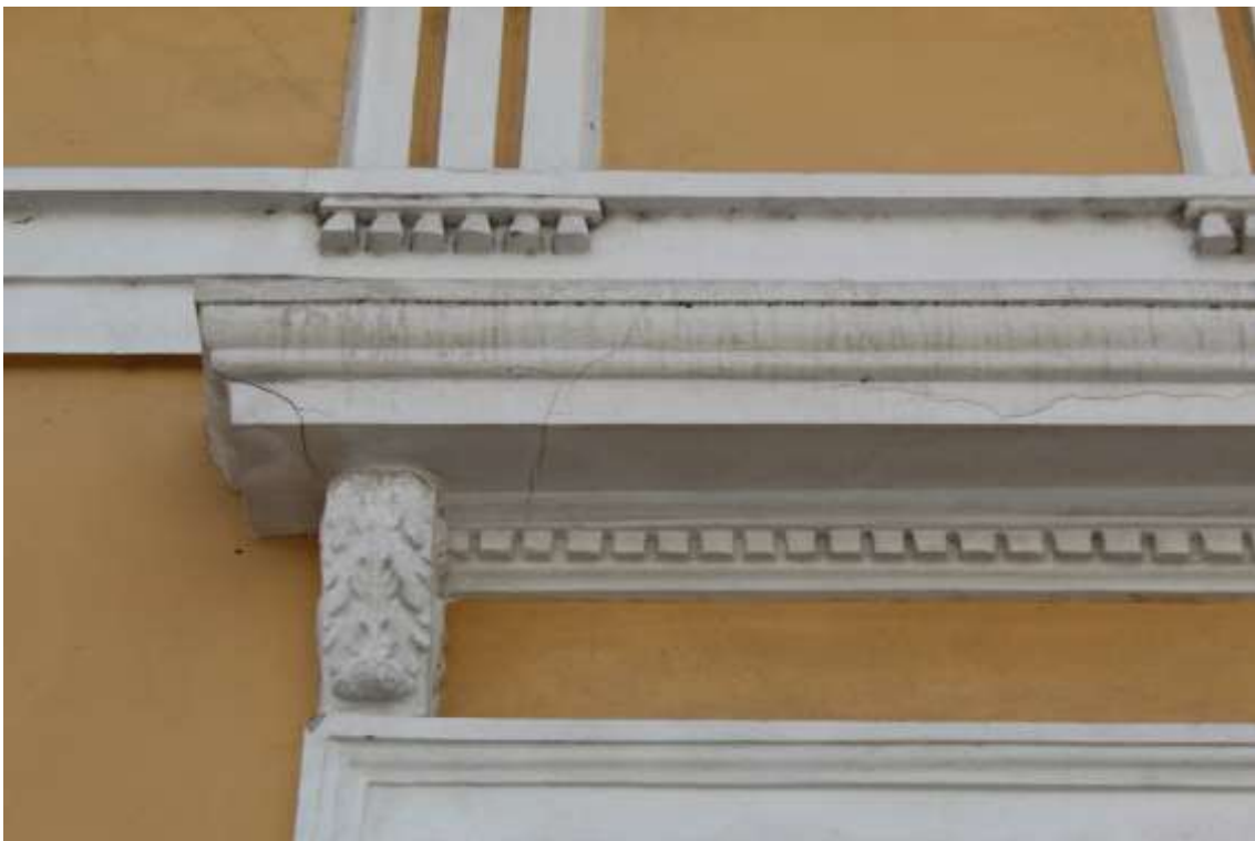
FIGURA 22 = FACHADA SUDESTE: fissuras na argamassa do ornamento
