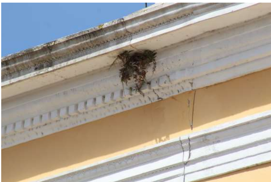
FIGURA 26 = FACHADA NOROESTE: vegetação a ser removida
