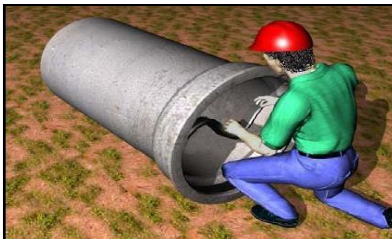
Figura 25 - Colocação do anel de borracha
