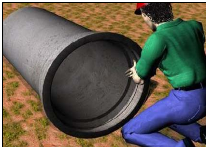
Figura 26 - Lubrificação do anel de borracha
