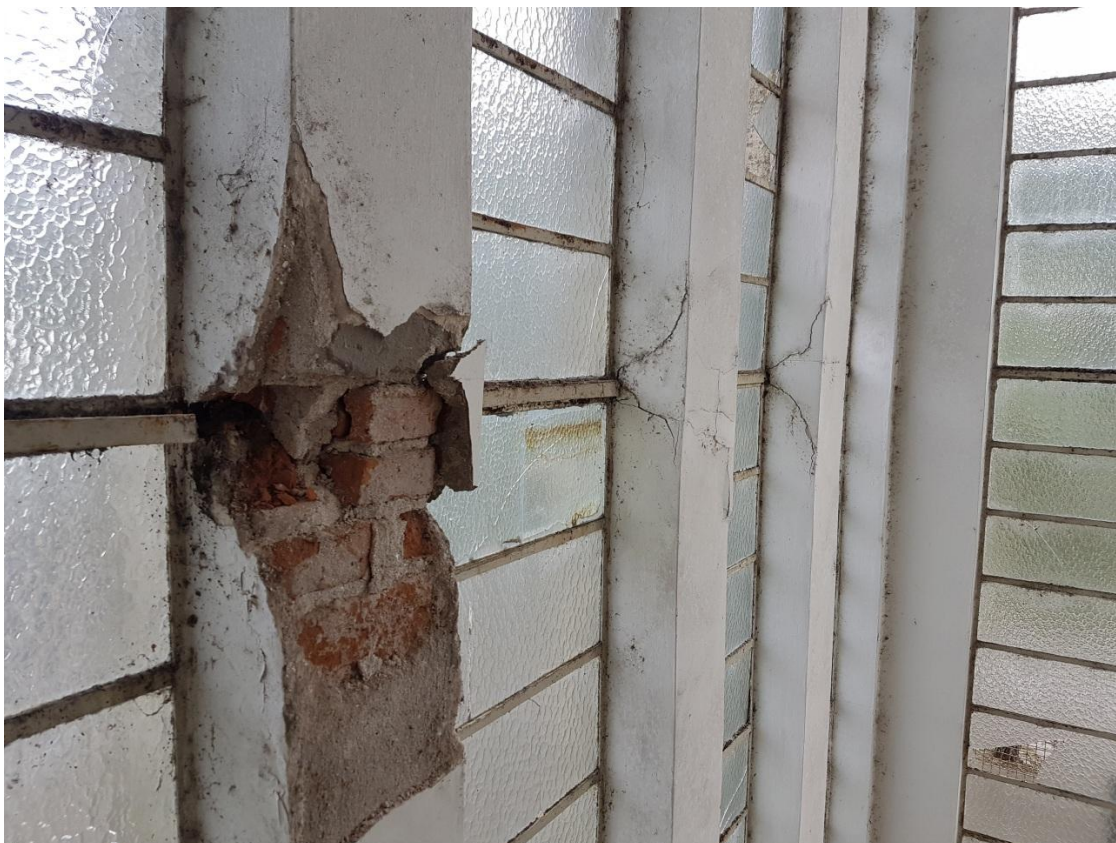
FIGURA 5 – Pilares a serem reparados na escada principal de acesso ao 2º Pavimento.
