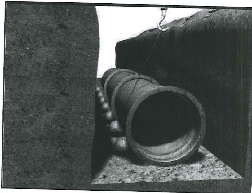
Figura 15– Alinhamento dos tubos com uso de calços
