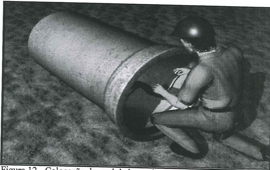
Figura 12 - Colocação do anel de borracha
