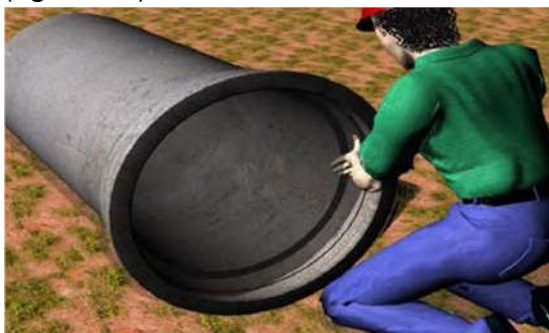
Figura 11 - Lubrificação do anel de borracha
