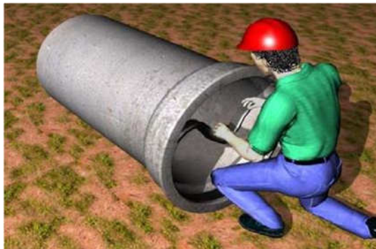
Figura 10- Colocação do anel de borracha
