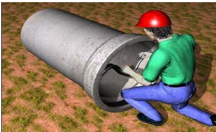
Figura 12 - Colocação do anel de borracha
