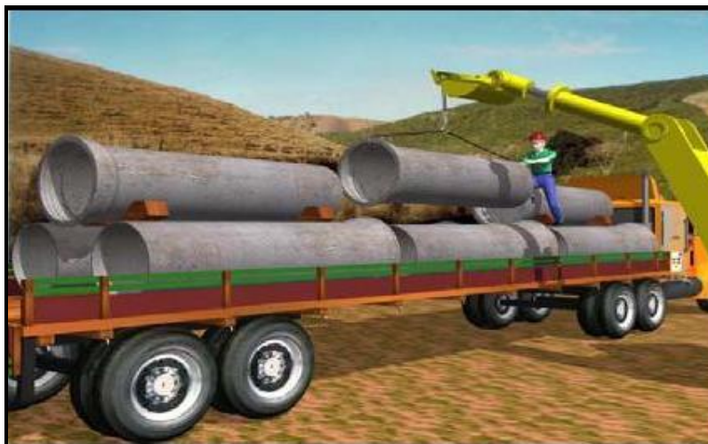
Figura 6 - Descarregamento dos tubos
