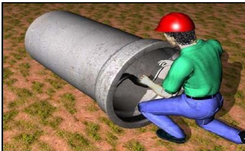
Figura 8 - Colocação do anel de borracha
