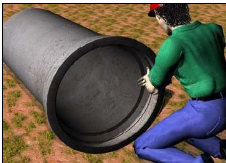
Figura 9 - Lubrificação do anel de borracha
