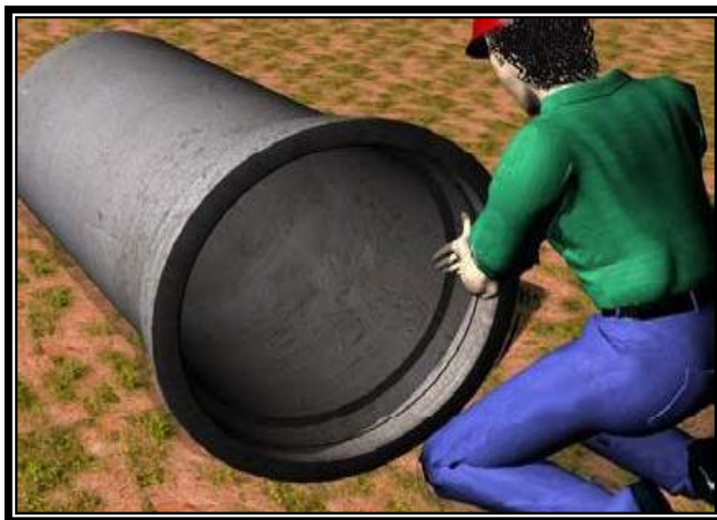
Figura 13 - Lubrificação do anel de borracha
