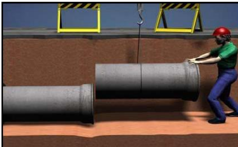
Figura 10 – Acoplamento de tubos de concreto
