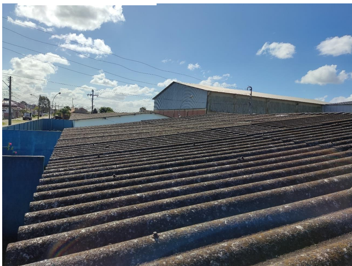
Figura 8 – Abaulamento do telhado
