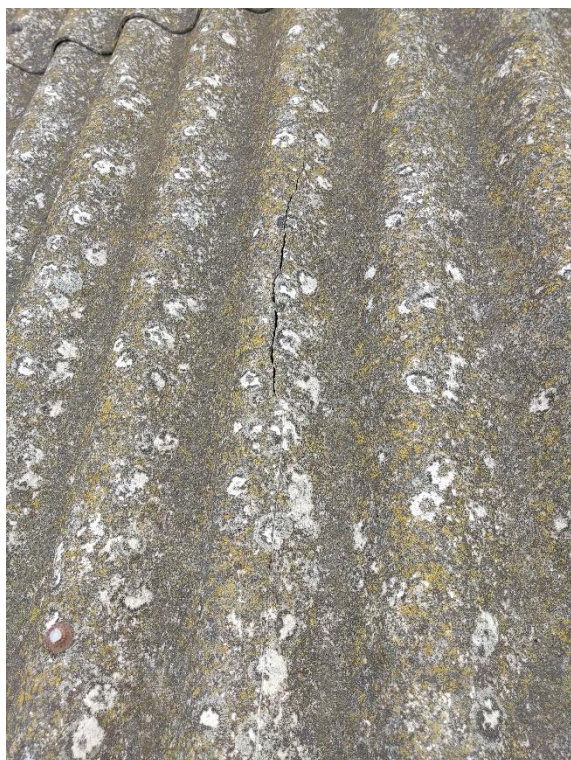
Figura 2 – Telha trincada
