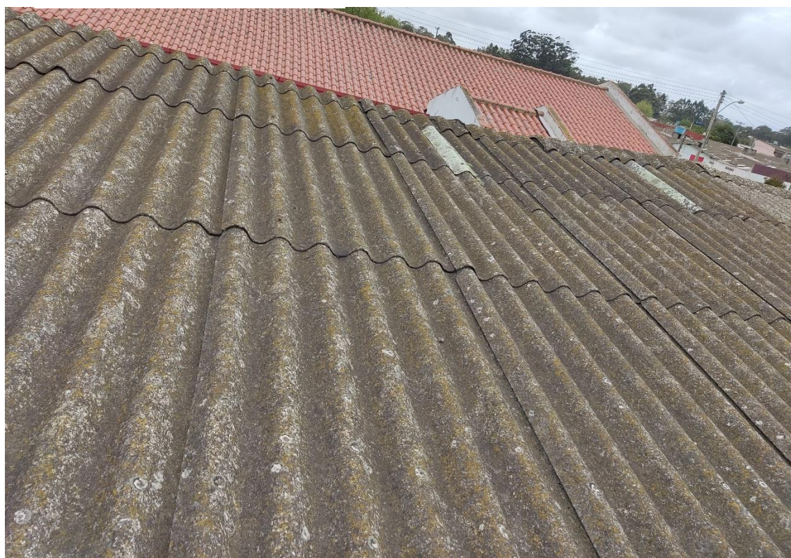
Figura 4 – Abaulamento do telhado
