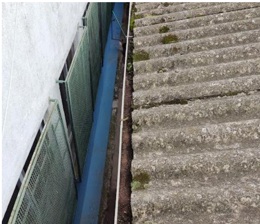
Figura 15 – Calha obstruída
