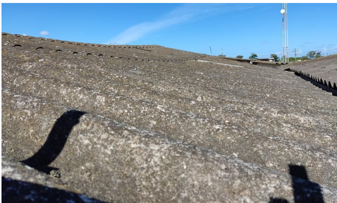
Figura 9 – Abaulamento no telhado do refeitório
