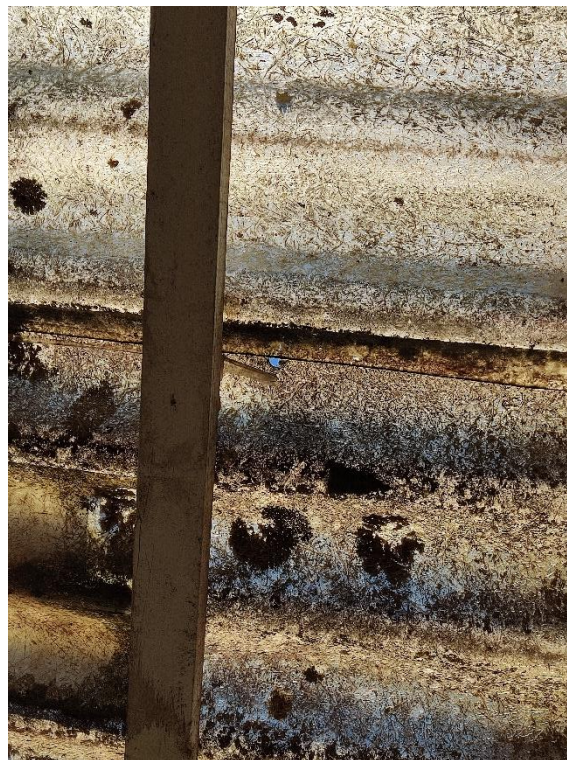
Figura 11 – Furos no telhado da despensa
