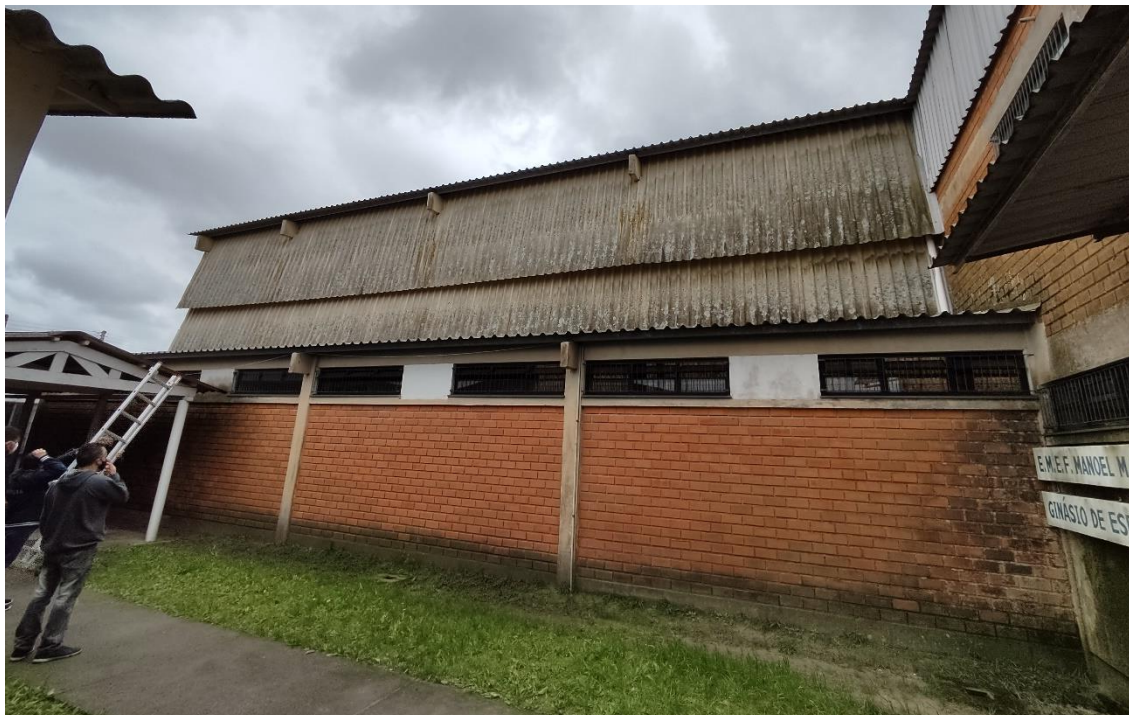
Figura 14 – Telhas translúcidas de fechamento lateral
