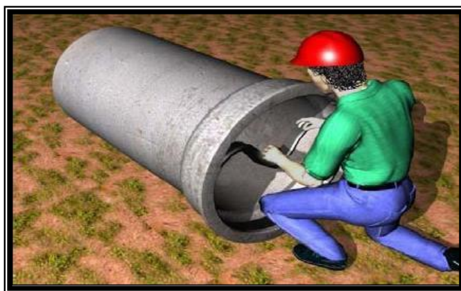
Ilustração 11 - Colocação do anel de borracha
