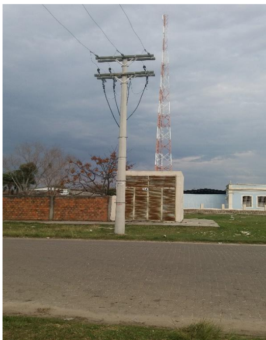
Poste derivação e subestação.
