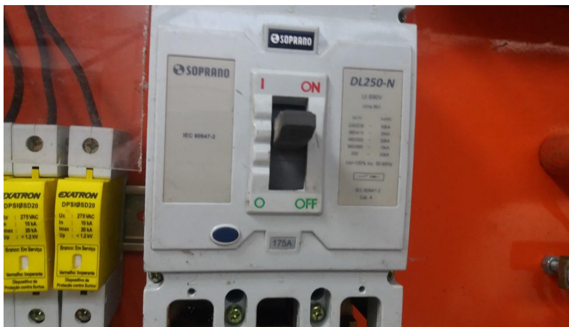
Disjuntor geral QGBT 02 que será instalado no QGBT 01.
