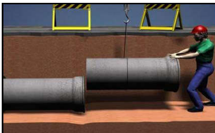
Figura 9 - Acoplamento de tubos de concreto
