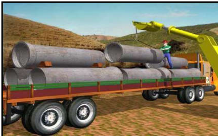
Figura 5 - Descarregamento dos tubos
