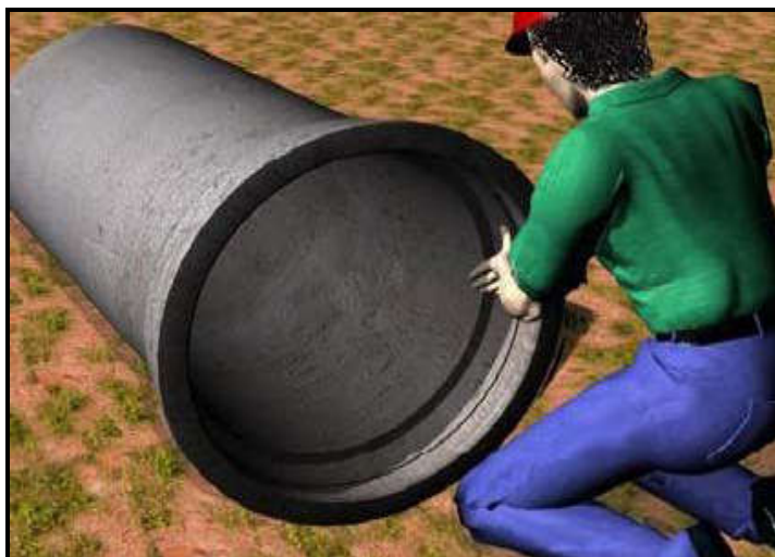
Figura 8 - Lubrificação do anel de borracha
