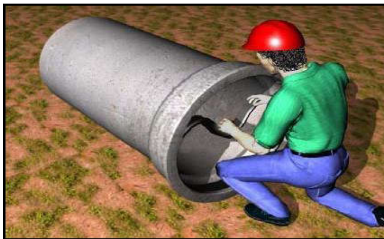
Figura 7 - Colocação do anel de borracha
