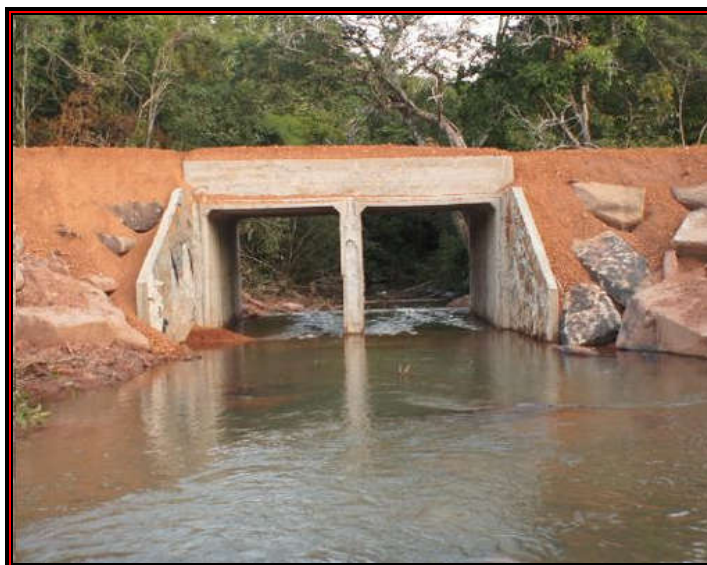
Figura 12 - Ala com duas aduelas de concreto
