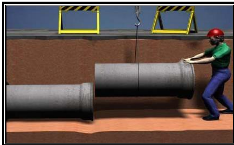
Figura 14 – Acoplamento de tubos de concreto
