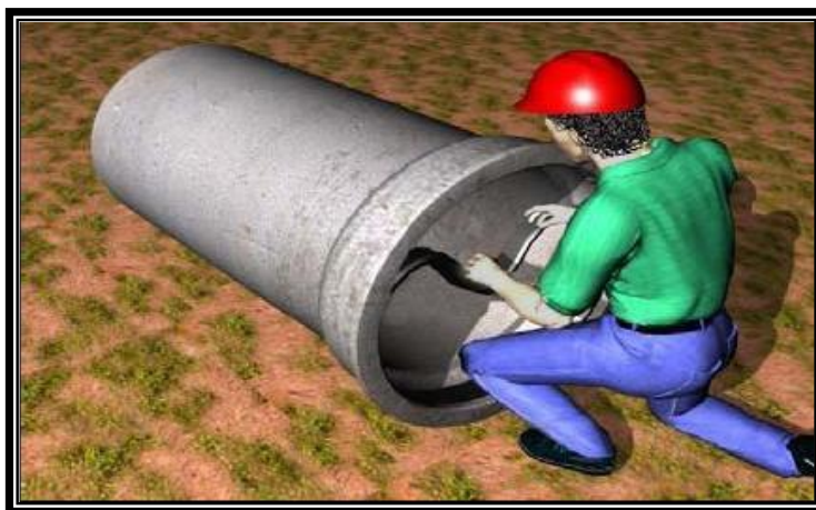
Figura 12 - Colocação do anel de borracha
