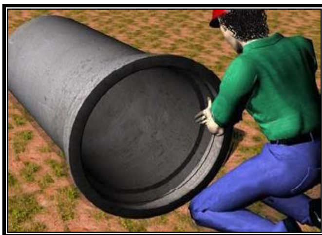
Figura 13 - Lubrificação do anel de borracha
