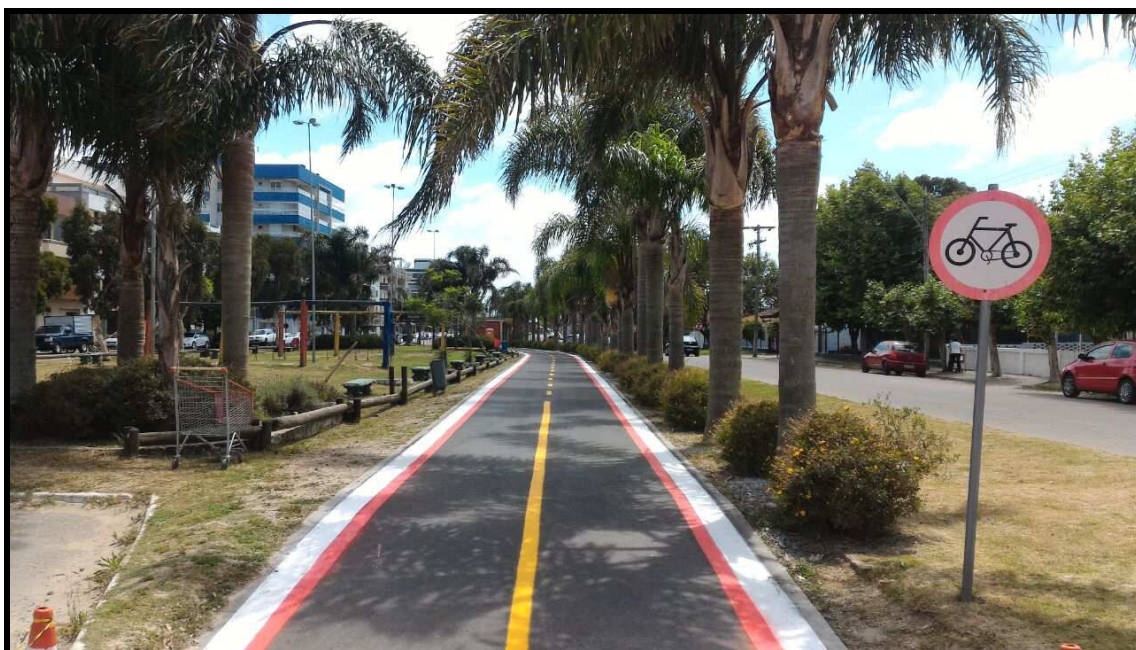
Figura 53: Pintura das faixas da sinalização horizontal na ciclovia da Av. Atlântica - Cassino
