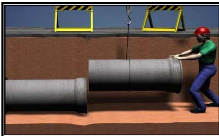
Figura 14 – Acoplamento de tubos de concreto
