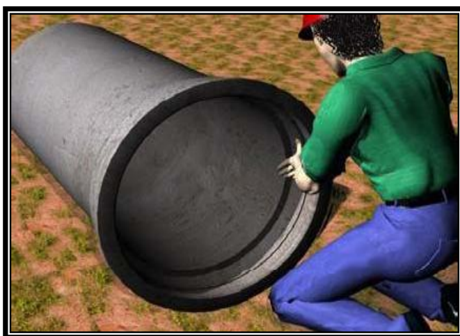
Figura 13 - Lubrificação do anel de borracha
