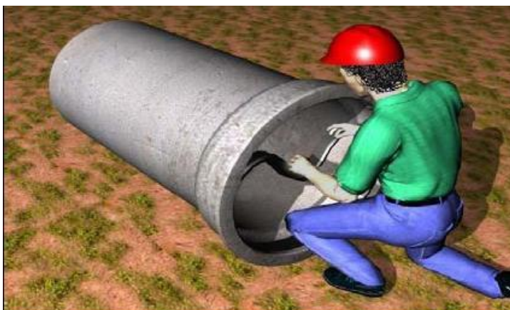
Figura 12 - Colocação do anel de borracha
