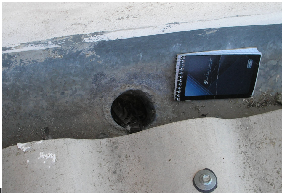
Vista da saída d'água de 75 mm existente hoje na calha.
