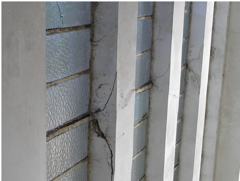
Reboco quebrado
