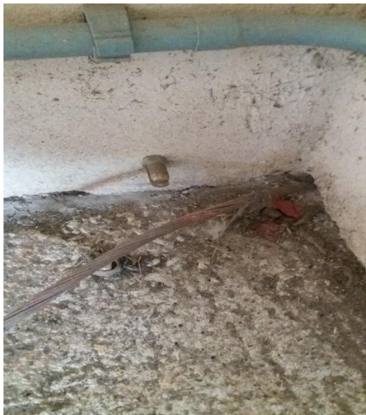
Aterramento danificado subestação
