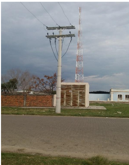
Poste derivação e subestação.
