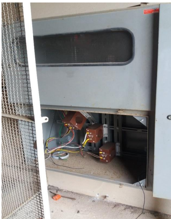
Caixa medição indireta à recuperar.
