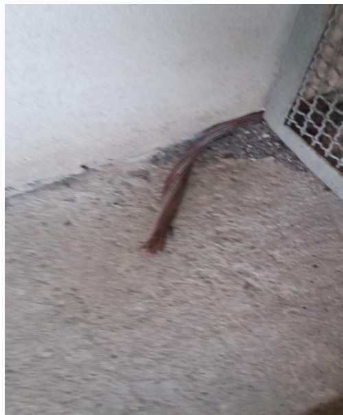
Aterramento danificado subestação
