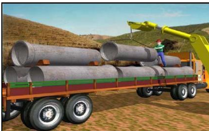
Figura 11 - Descarregamento dos tubos
