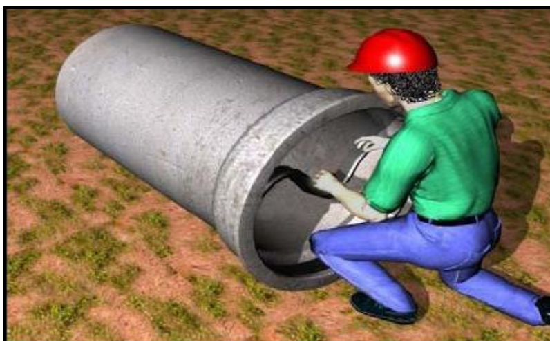
Figura 13 - Colocação do anel de borracha
