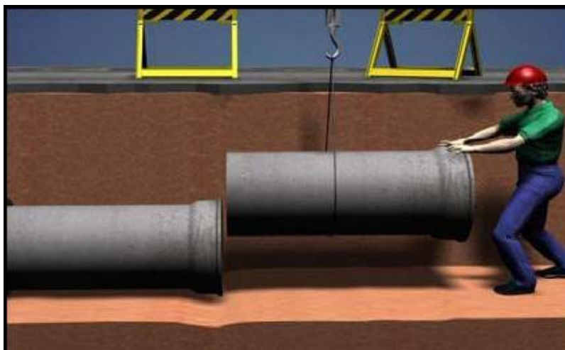
Figura 15 – Acoplamento de tubos de concreto
