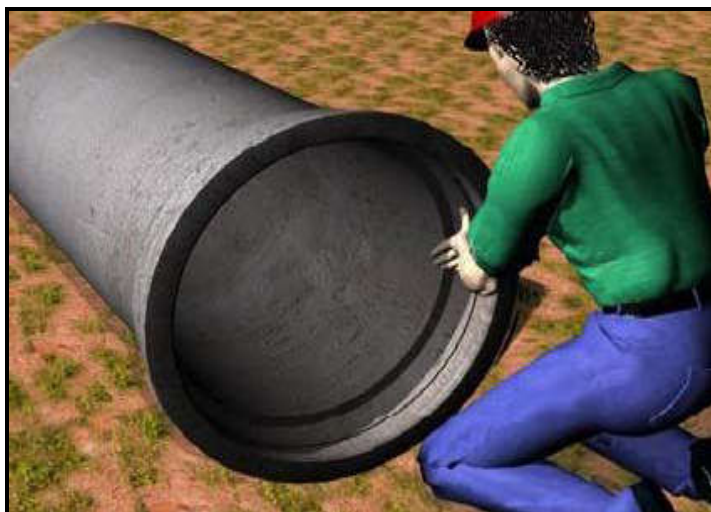
Figura 16 - Lubrificação do anel de borracha
