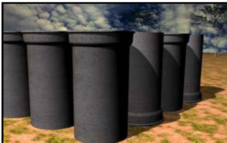
Figura 14 - Tubos estocados na posição vertical
