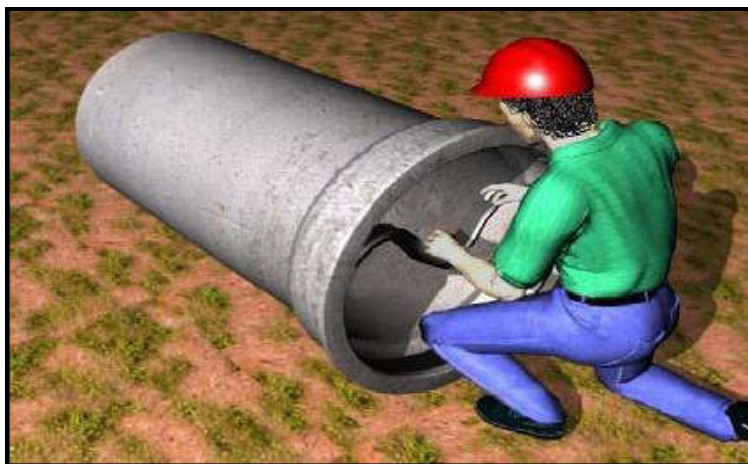
Figura 15 - Colocação do anel de borracha
