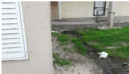
Caixa de gordura sem ligação na rede coletora
