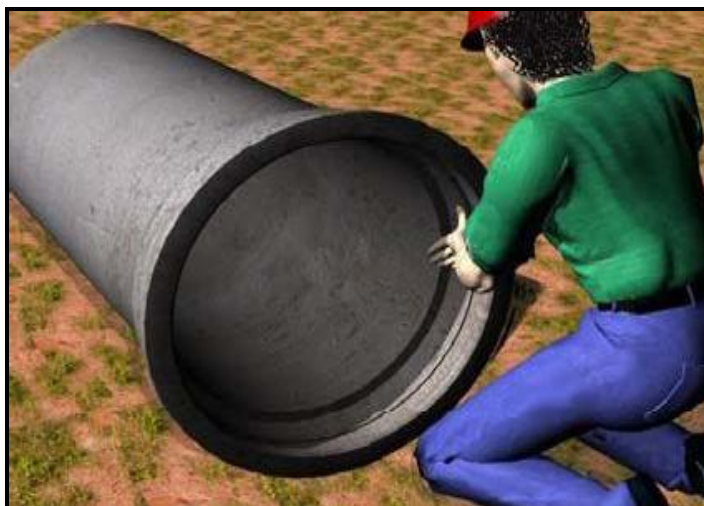
Figura 33 - Lubrificação do anel de borracha
