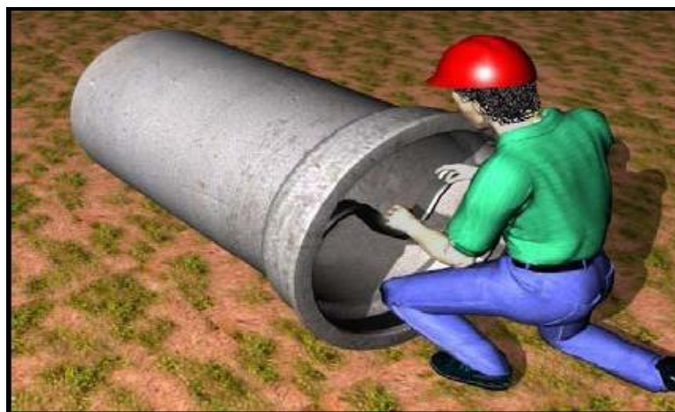
Figura 32 - Colocação do anel de borracha
