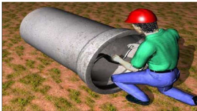
Figura 16 - Colocação do anel de borracha
