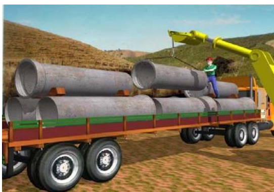
Figura 02. Descarregamento dos tubos
