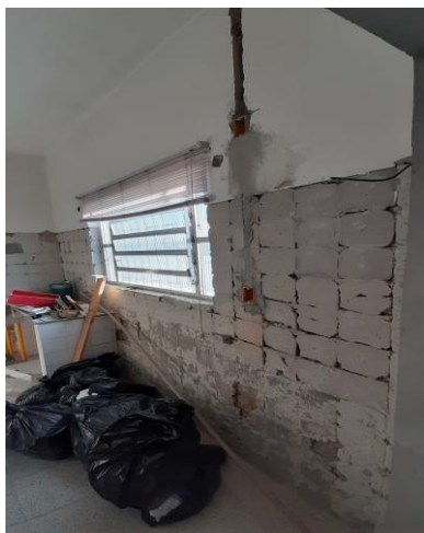
Figura 07 – Rasgo na parede independente p/ tubulação circuito ar condicionado.
