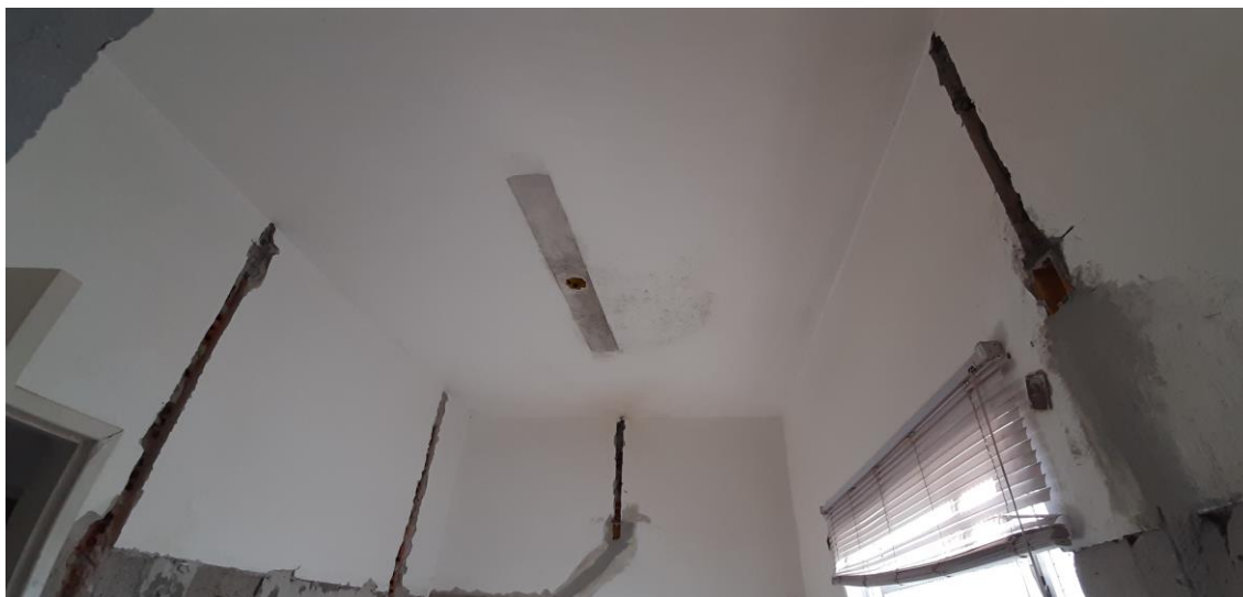
Figura 02 – Caixa octagonal existente para Ponto de Iluminação.
