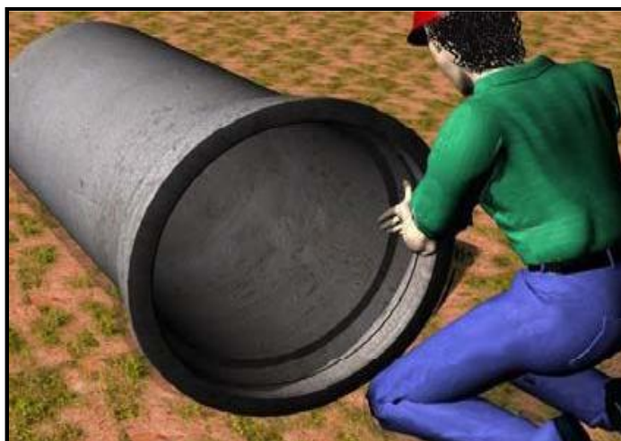
Figura 50 - Lubrificação do anel de borracha
