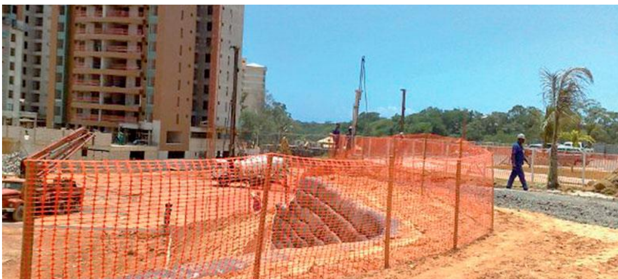
Figura 2 – Exemplo do uso de telas plásticas para isolamento
