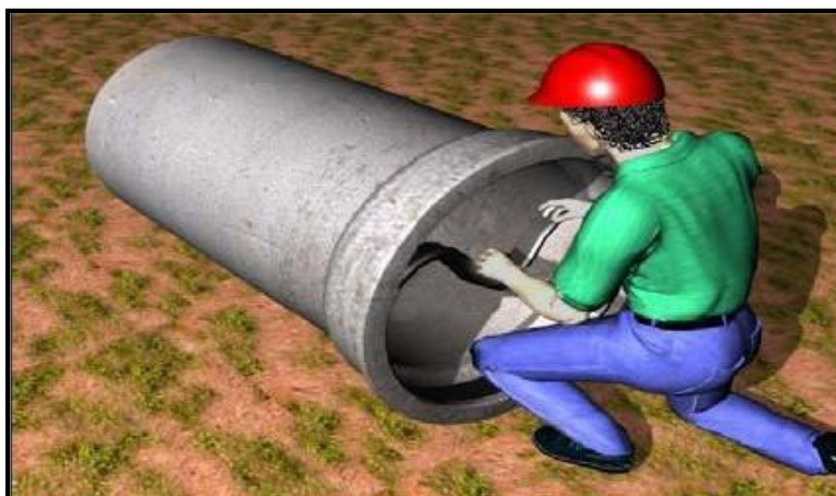
Figura 27 - Colocação do anel de borracha
