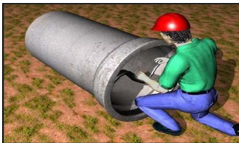
Figura 49 - Colocação do anel de borracha
