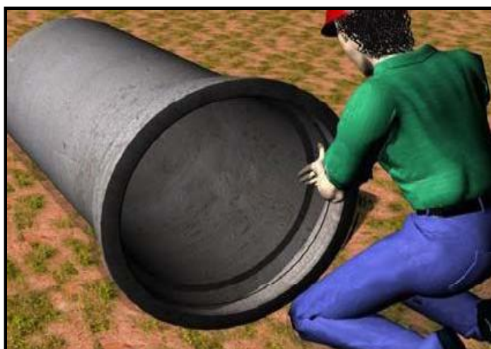
Figura 28 - Lubrificação do anel de borracha
