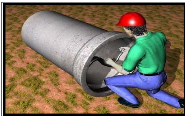
Ilustração 22 - Colocação do anel de borracha
