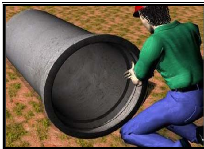
Ilustração 23 - Lubrificação do anel de borracha
