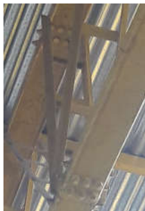
Emenda parafusada
