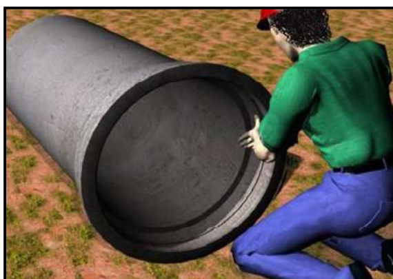
Figura 23 - Lubrificação do anel de borracha
