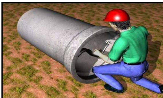
Figura 22 - Colocação do anel de borracha
