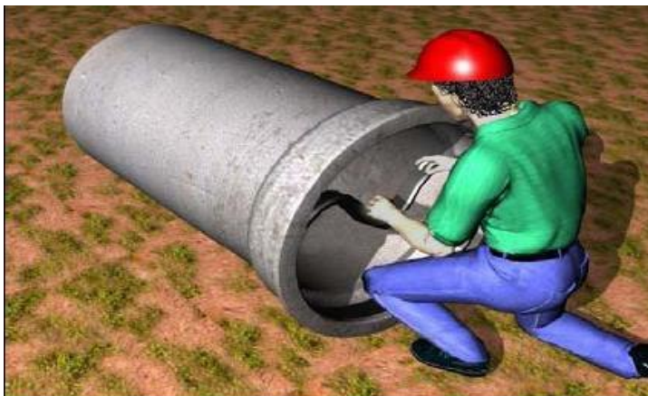
Figura 12 - Colocação do anel de borracha
