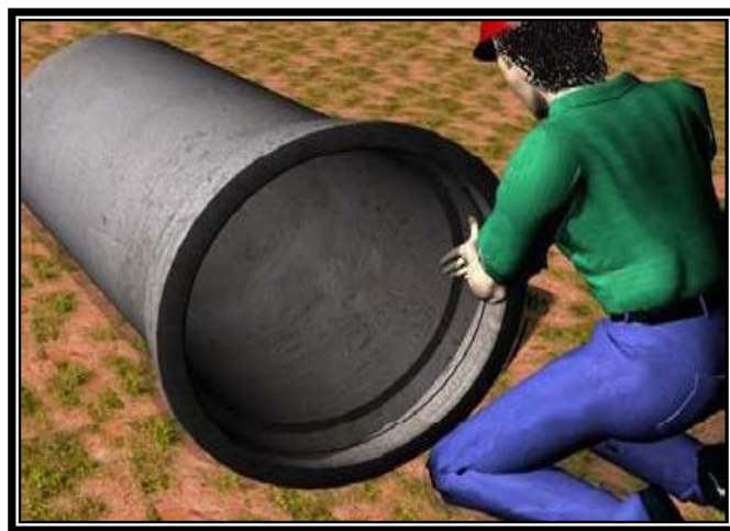
Figura 13 - Lubrificação do anel de borracha
